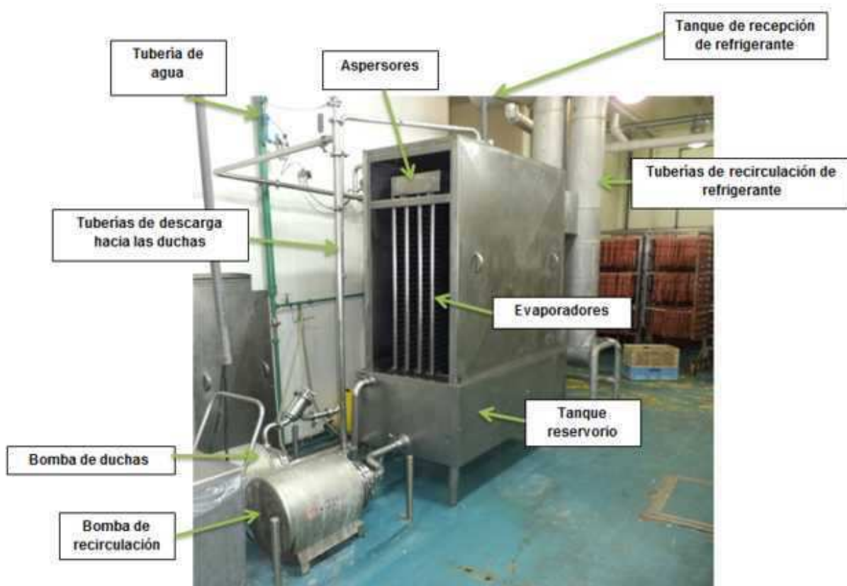
Figura N° 2.15 Partes importantes del sistema chiller
