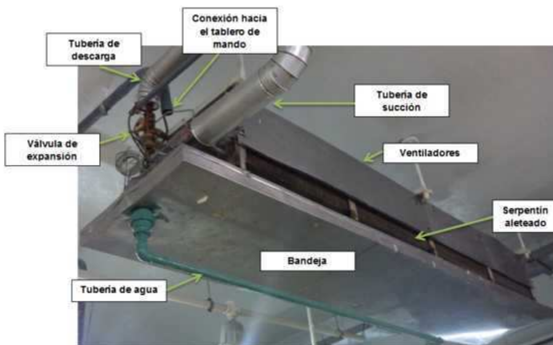
Figura N° 2.6 Partes principales de un típico evaporador del sector de elaboración
