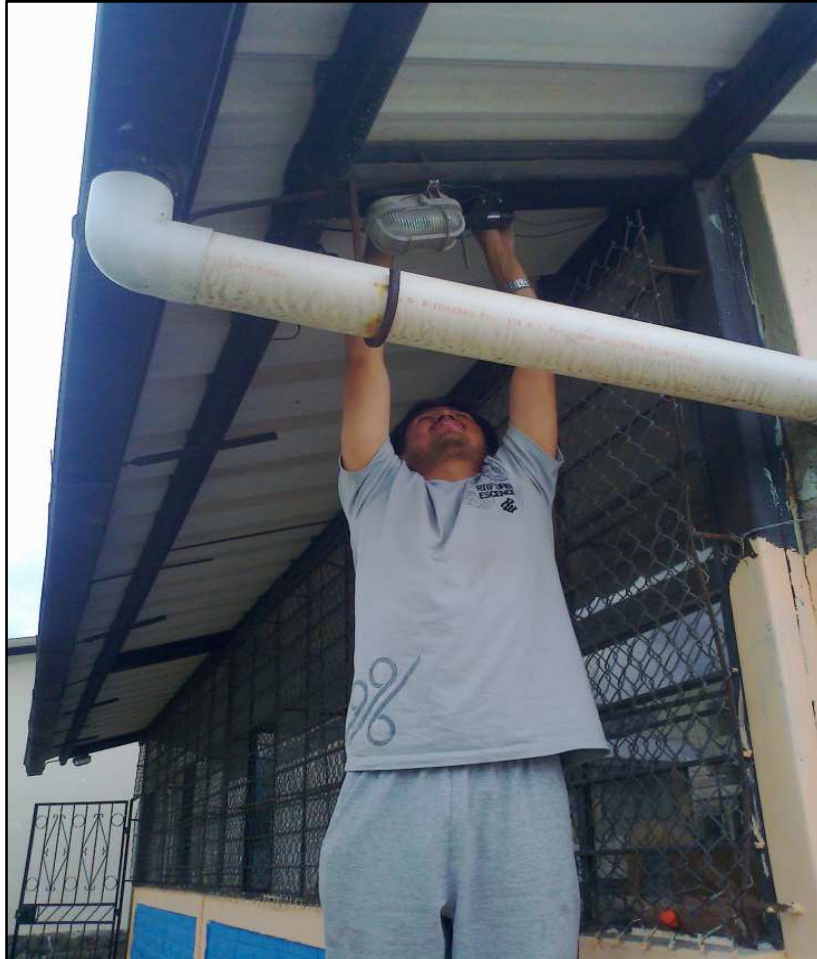
Figura N. 4.15: Instalación del • AP D-LINK DWL-2100AP Fuente: Realización In Situ, Darwin Fernando Adriano
