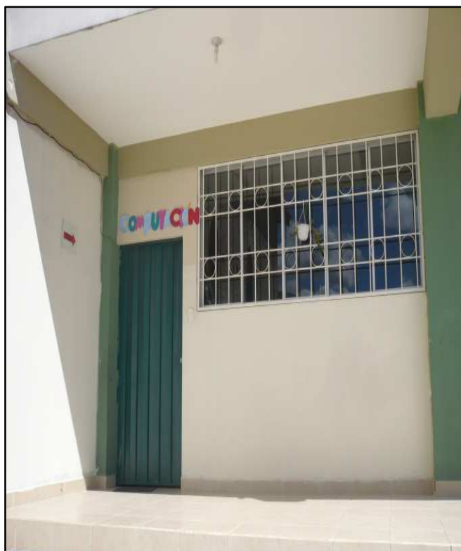
Figura N. 3.5: Aulas y Salón de Uso Múltiple Fuente: Observación in situ
