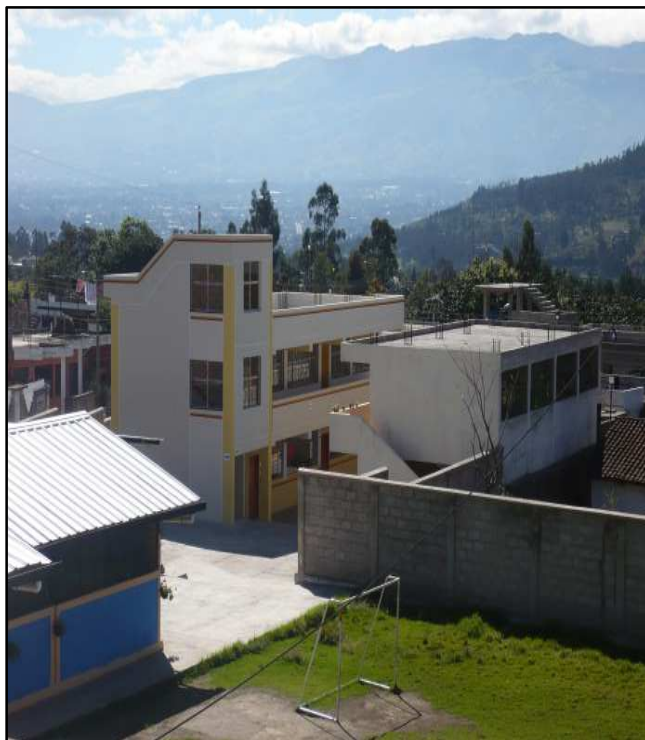
Figura N. 3.4: Aulas y Salón de Uso Múltiple Fuente: Observación in situ
