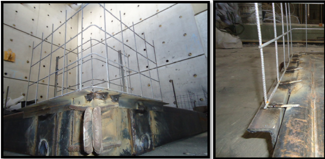
Figura 5-7: Conexión de malla y ángulos, sobre la plataforma de acero
