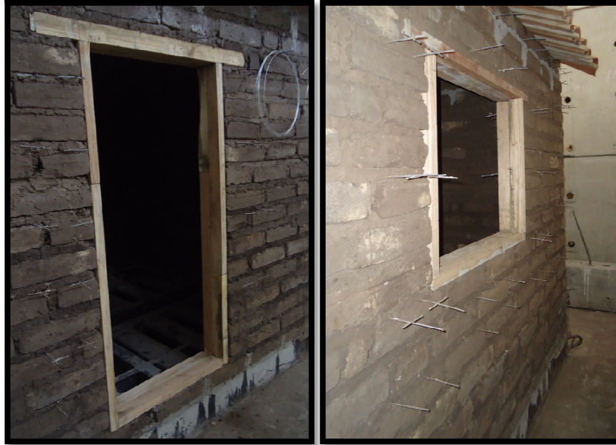
Figura 5-33: Marcos de madera en puertas y ventanas
