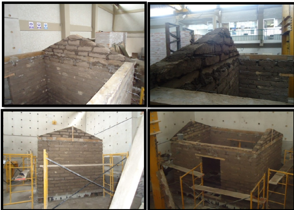
Figura 5-27: Construcción de las culatas
