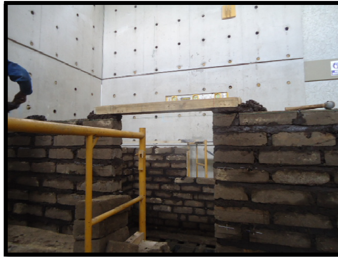
Figura 5-16: Dintel sobre puerta y ventana
