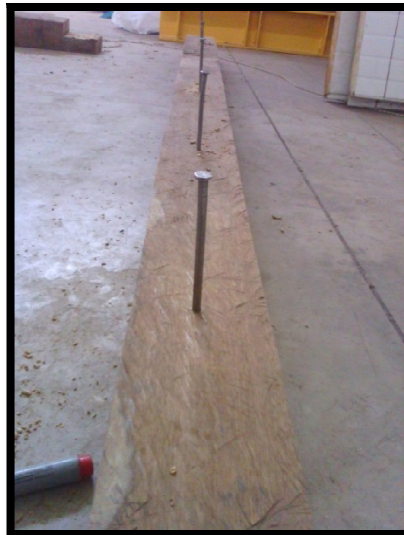
Figura 8-2: Chicotes colocados en la solera para apoyo del tímpano
