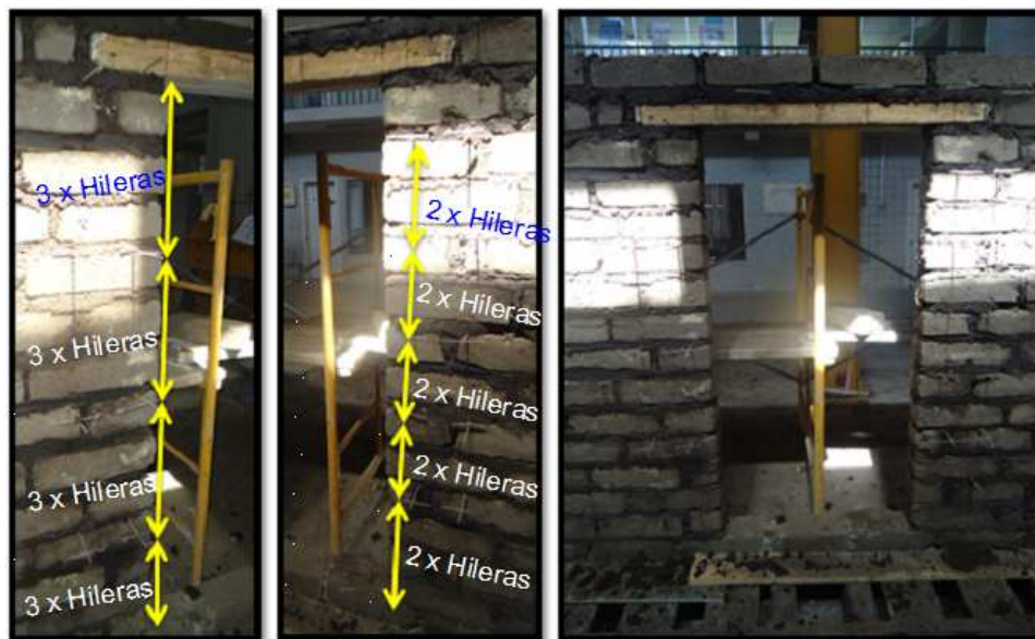
Figura 8-4: Distribución de conectores en puerta
