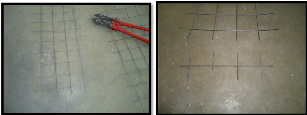
Figura 5-11: Retazos de malla de anclaje para el traslape de la malla electrosoldada de refuerzo
