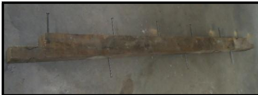
Figura 5-24: Colocación de clavos tirafondos sobre las vigas más cortas para el anclaje de las culatas
