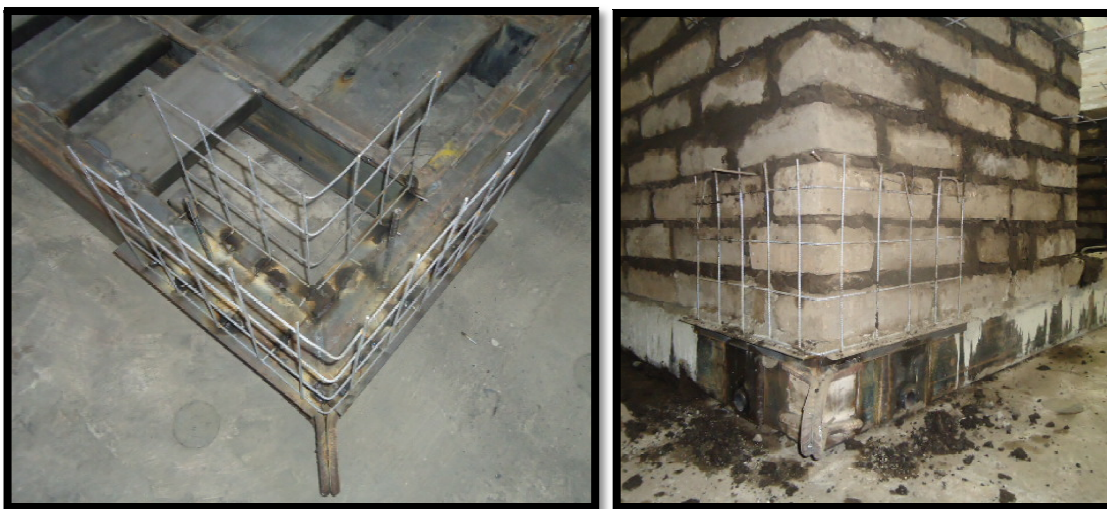
Figura 8-3: Longitud para el traslape entre mallas
