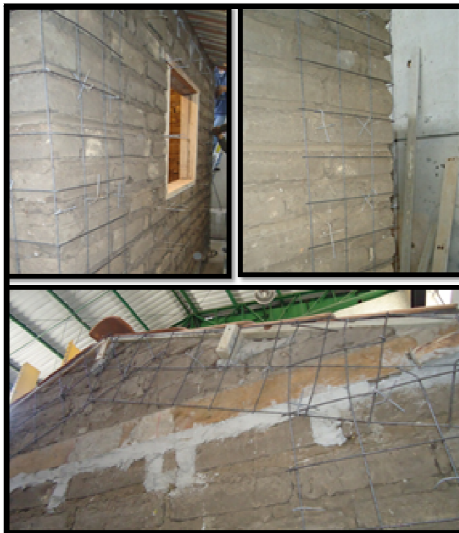
Figura 5-35: Aseguramiento de la malla electrosoldada con alambre galvanizado
