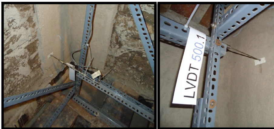
Figura 7-4: Colocación de LVDT's al interior del prototipo
