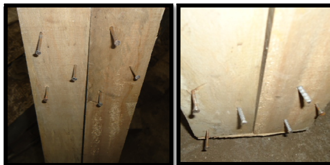
Figura 5-15: Clavos colocados sobre las tiras de madera para dinteles
