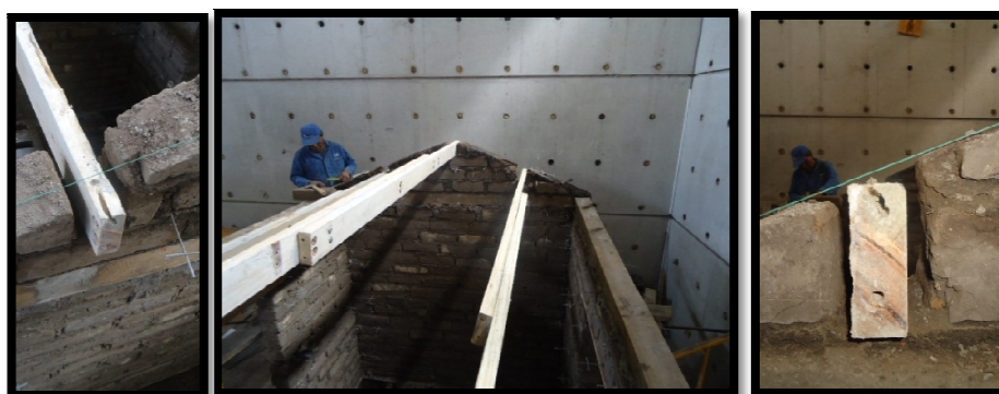
Figura 5-28: Ubicación de las correas sobre las culatas
