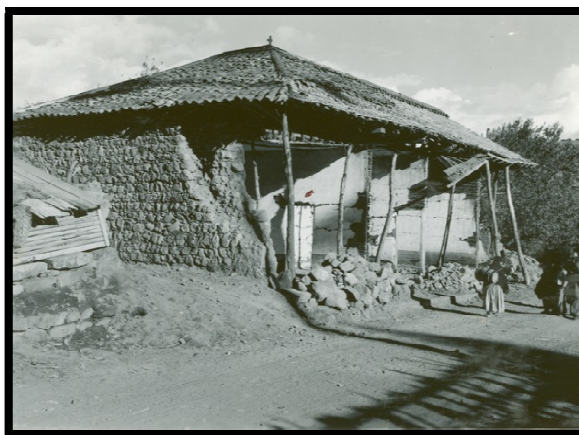
Figura 1-4: Casa de Adobe afectada por terremoto de Ambato de 1949
