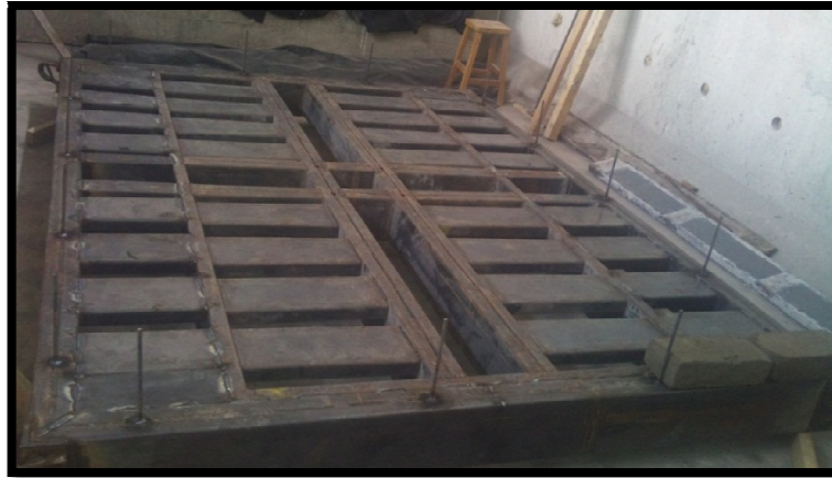
Figura 5-5: Chicotes para el anclaje de bloques (Primera hilera)
