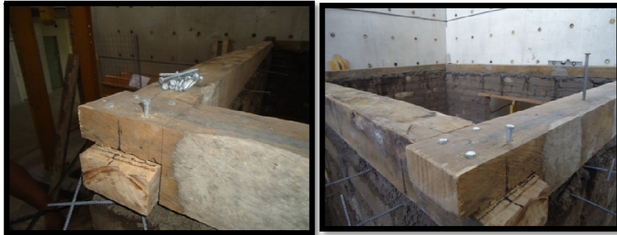
Figura 5-26: Conexión entre vigas soleras con tirafondos
