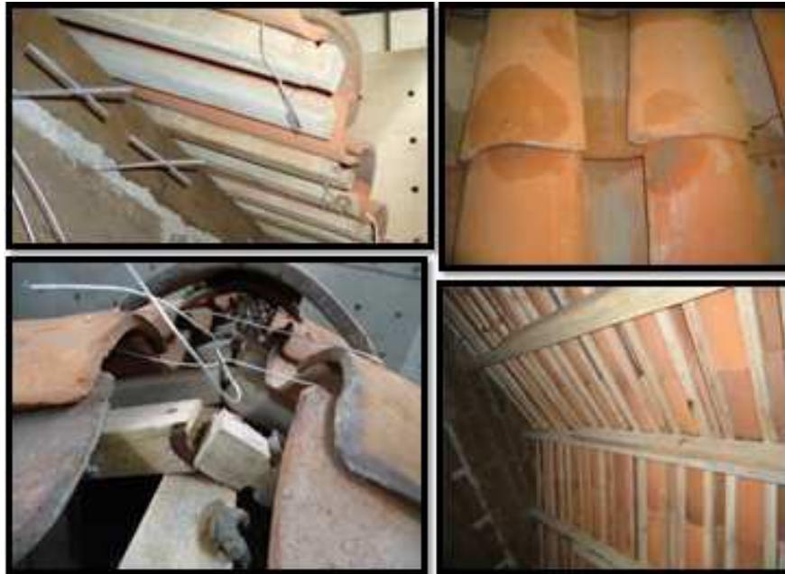
Figura 5-31: Amarre de tejas con alambre galvanizado
