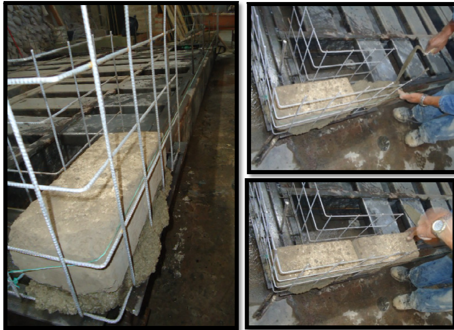
Figura 5-8: Colocación de la primera hilera con mezcla de cemento y arena
