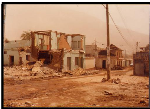
Figura 1-5: Casa afectada en el sector de Pomasquí por el sismo del 10 de Agosto de 1990.
