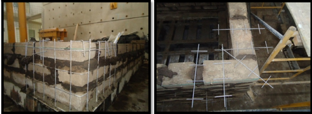
Figura 5-14: Malla de anclaje y conectores en las tres primeras hileras
