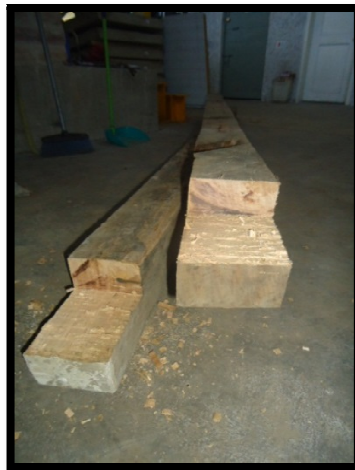
Figura 5-22: Destaje realizado en los extremos de cada viga solera
