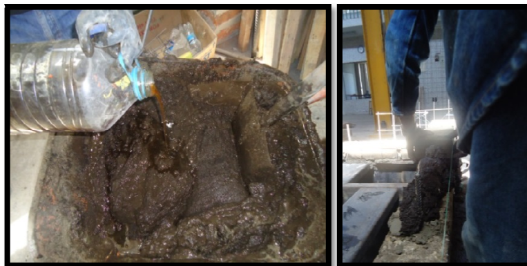
Figura 5-9: Colocación de panela diluida en agua, como aditivo aglutinante de pega
