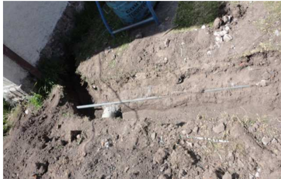
Figura 3-12: Zanja para el cableado vertical
