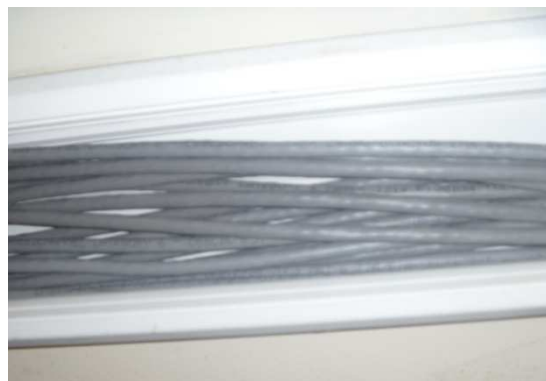
Figura 3-2: Tendido de cables
