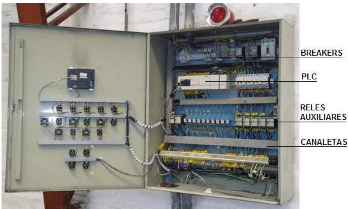
Figura 3.9 Montaje de nuevos elementos eléctricos en el interior del armario.
