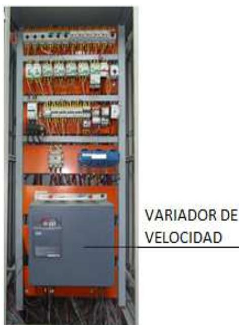
**Figura 2.7 Tablero de control eléctrico.**
