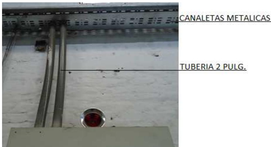
**Figura 3.6 Instalación de tubería y canaletas metálicas.**
