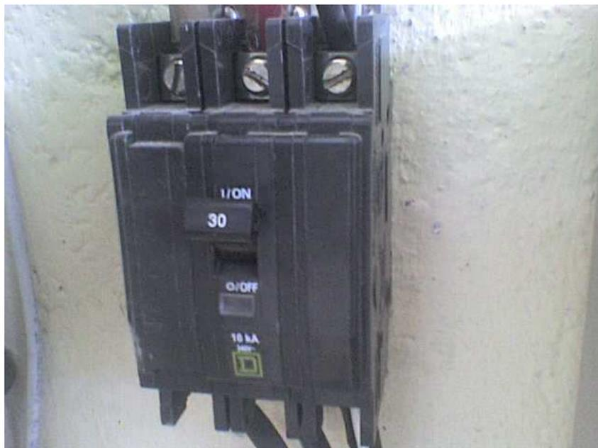
**Figura 1.7** Montaje del disyuntor general
