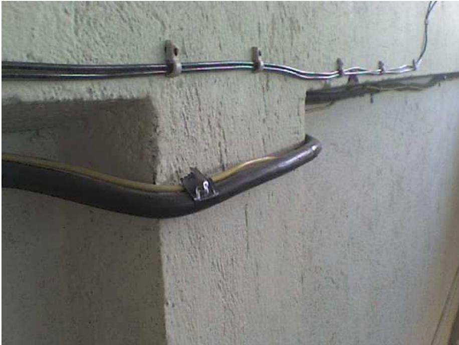
**Figura 1.11** Instalación de los cables del circuito de fuerza
