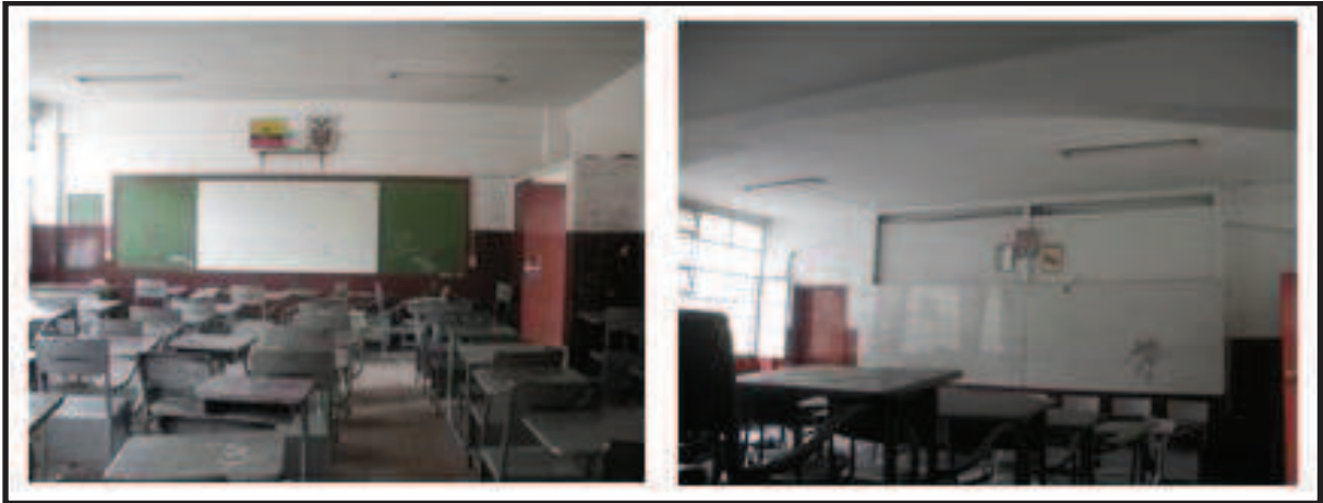
Foto 2.14.: Estado Actual de Iluminación en Aulas.
