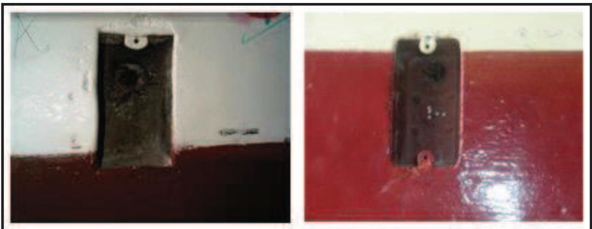
Foto 2.15.: Estado Actual de los Interruptores en Aulas.
