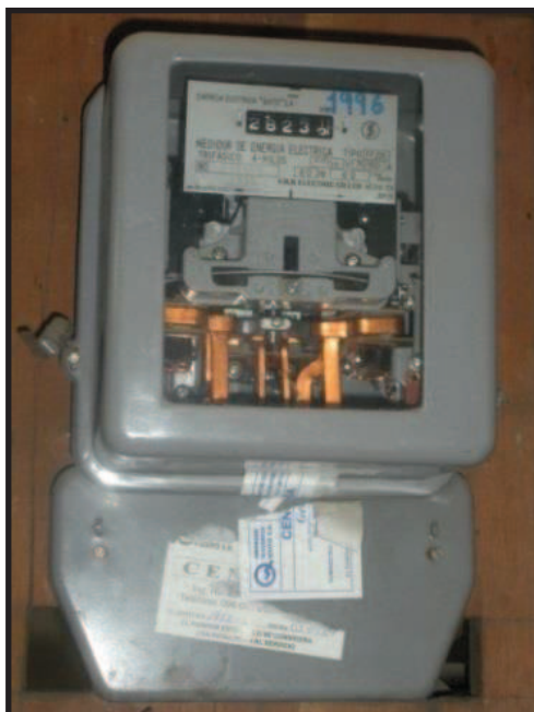
Foto 2.2.: Contador de Energía Eléctrica.
