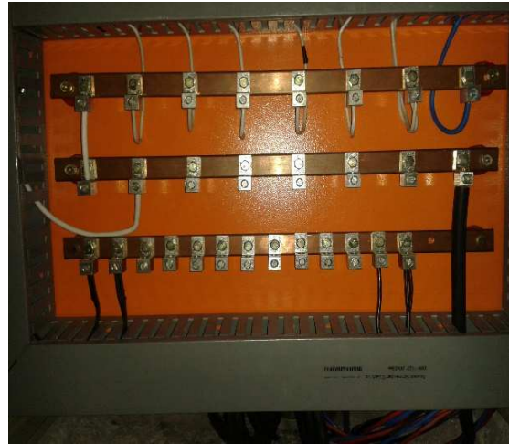
Figura 5.8.- Esquema de barras para neutro.
