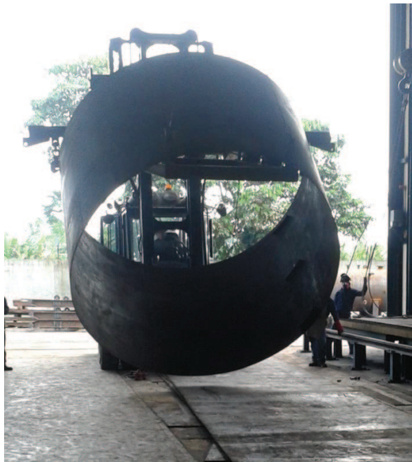
Figura 1-13 Fabricación de cilindros para tanques.
