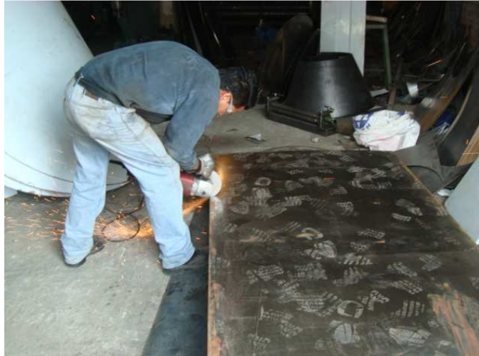
Figura 5.1.- Corte con amoladora de la plancha de acero A36.
