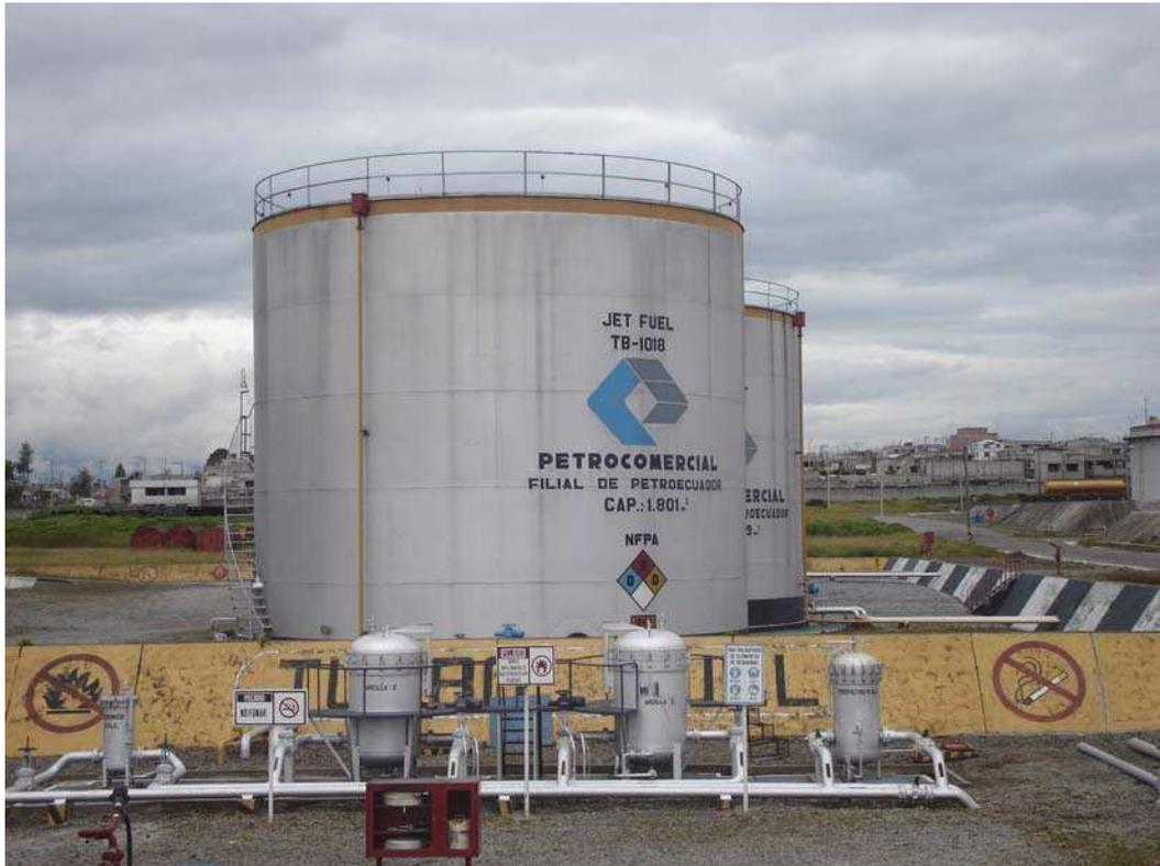
Figura 2.8. Tren filtrante de la Planta Jet Fuel
