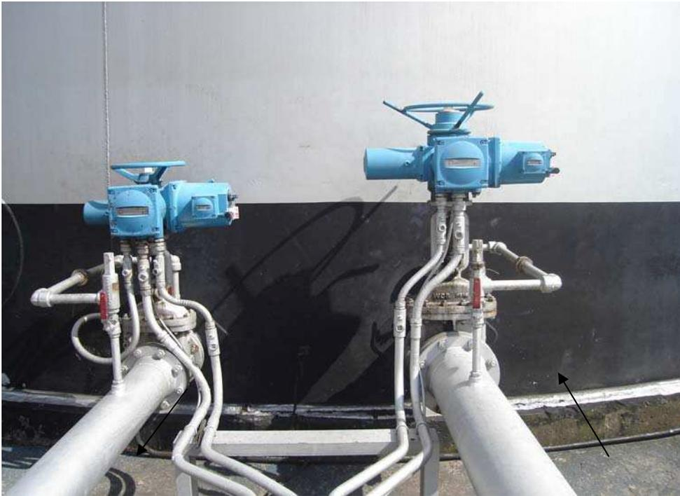
Figura 2.6. Actuadores Eléctricos montados en los tanques
