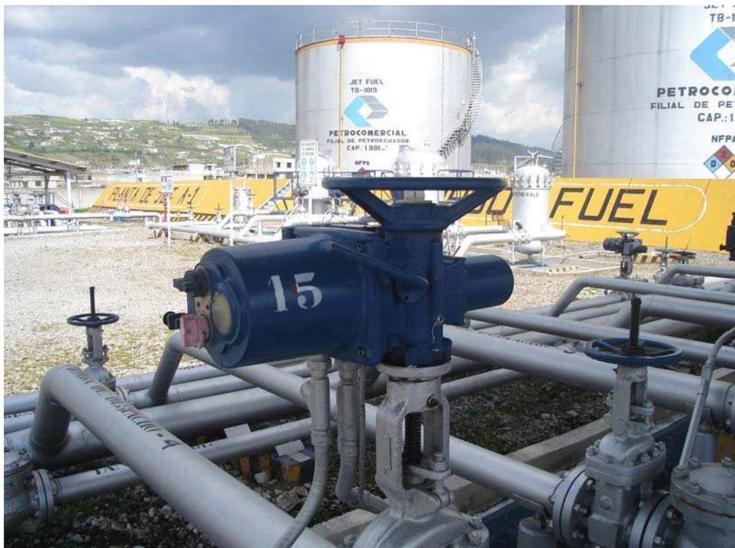
Figura 2.5. Actuador Eléctrico para válvula de multi-vuelta
