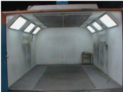
**Imagen B.35. Ventilación Extractiva localizada de la cabina**
