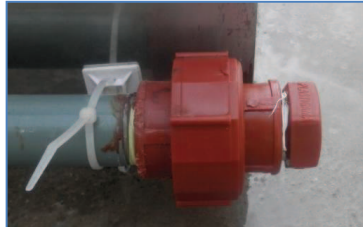
Figura 2. Salida del agua, Desagüe General
