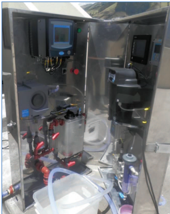
Figura 4.28 Pruebas del Módulo con Agua Limpia
