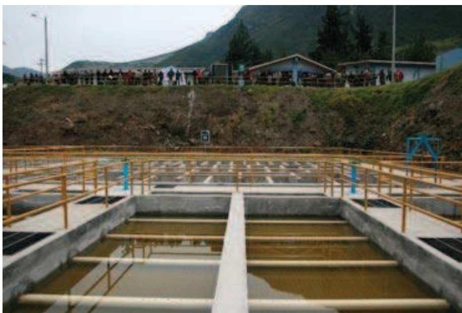
Figura 1.3 Planta de Tratamiento de Agua Paluguillo[3]
