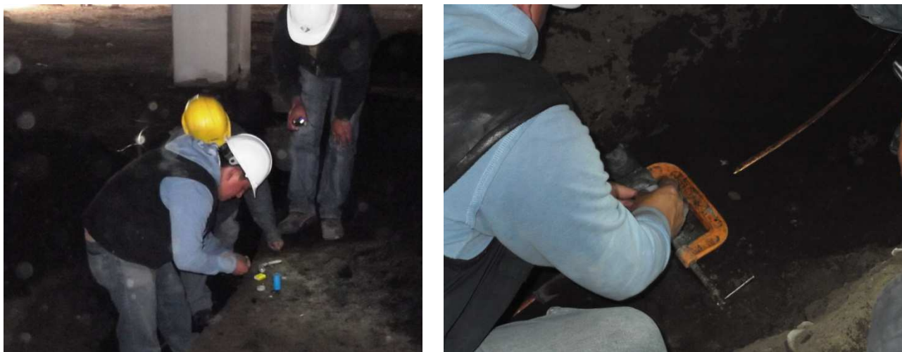
Figuras 4.14 y 4.15 Preparación del punto de suelda
