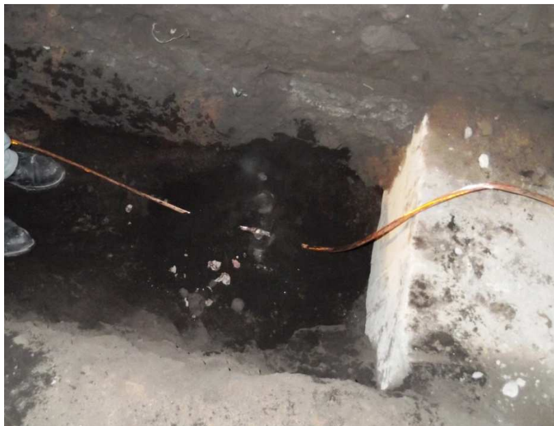
Figura 4.17 Tierra con polvo de carbón vegetal junto a varilla
