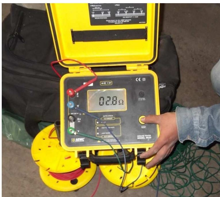
Figura 4.11 Medición de resistencia de la malla terminada
