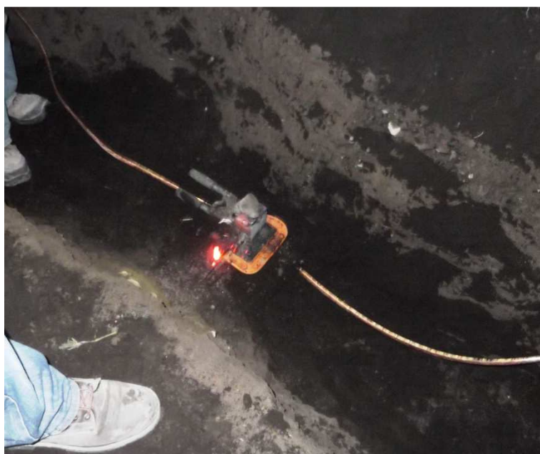
Figura 4.16 Punto de suelda varilla-cable
