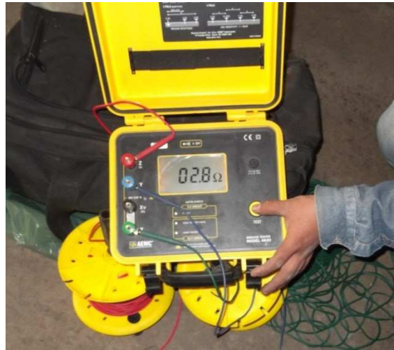
Figura 4.9 Medición de resistencia de la malla terminada
