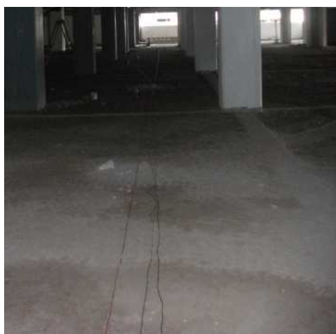
Figura 4.8 Medición de la puesta a tierra en el Mercado del Salto Latacunga.
