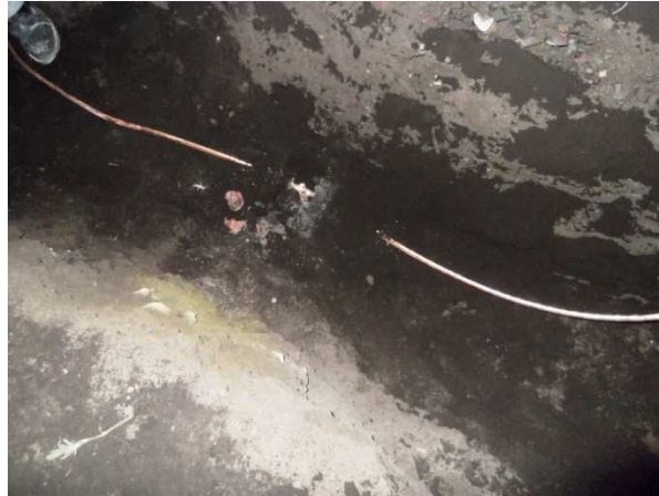
Figura 4.12 Profundidad de la zanja para la instalación de la malla.
