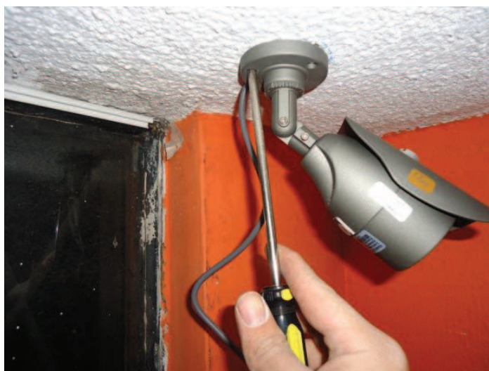
Figura 3.20 Anclaje de cámaras
