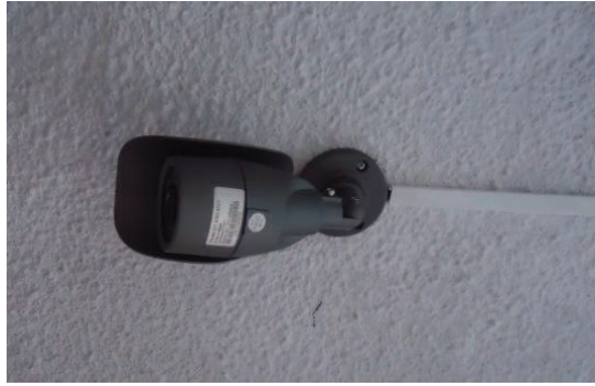
Figura 3.21 Cámara anclada al techo
