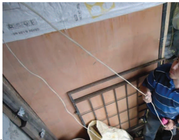
Figura 3.18 Instalación de cable
