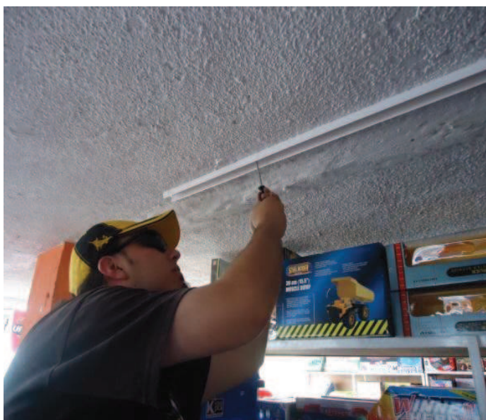
Figura 3.13 Instalación de canaletas
