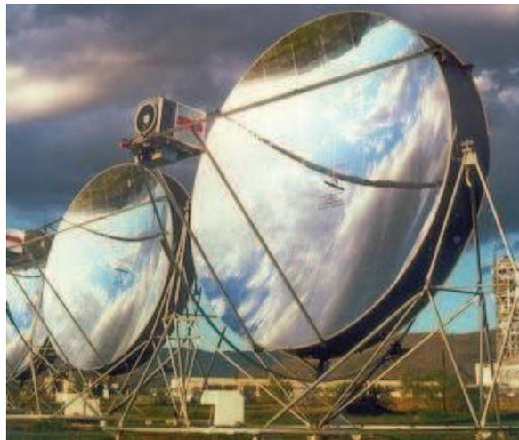
**Figura 2. 17 Concentrador Paraboloide de Revolución**
