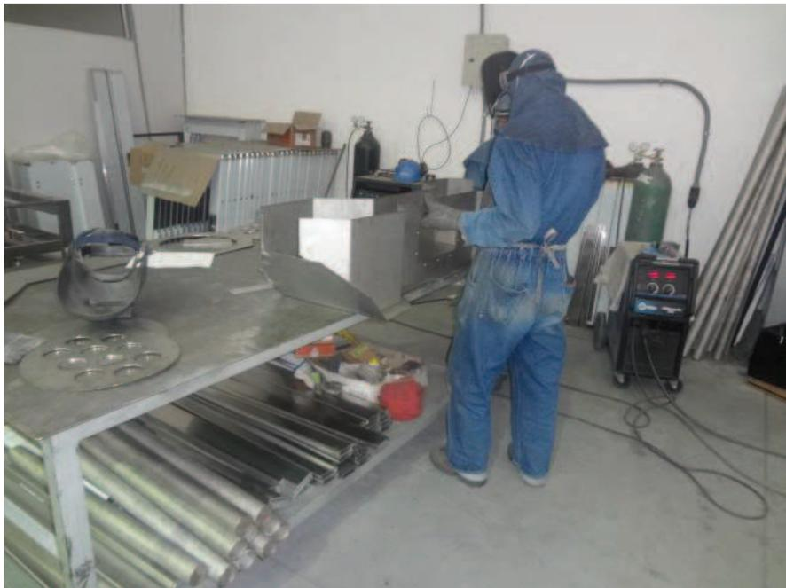
**ENSAMBLE DE LAS PLANCHAS EXTERIORES CON LANA DE VIDRIO**
