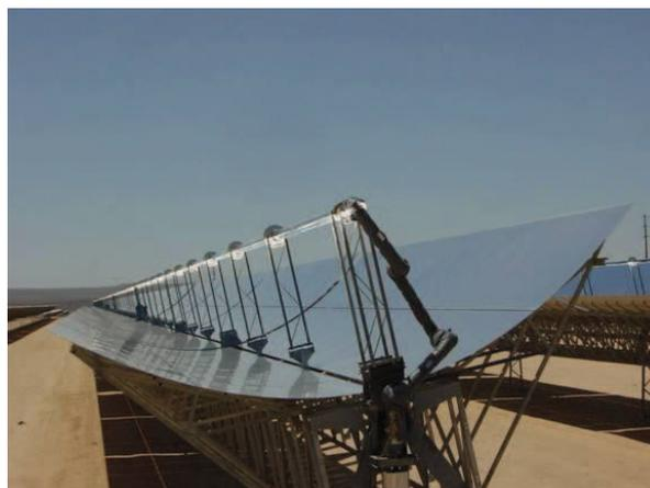
**Figura 2. 16 Concentrador cilíndrico parabólico.**
