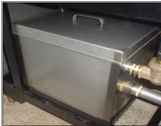
Figura 2.15 b) Tanque de agua
