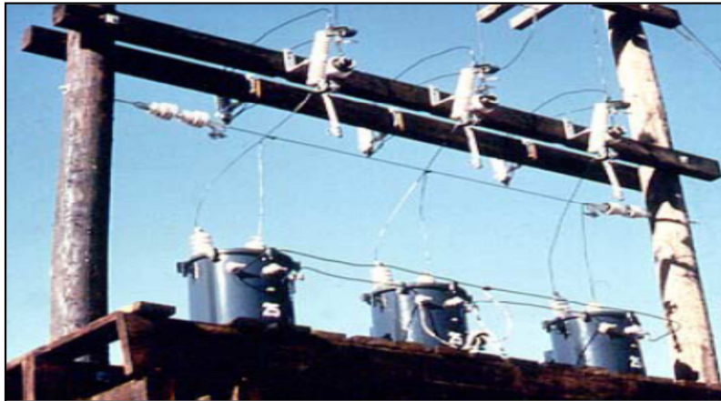
Figura 2.7 Transformador reductor
