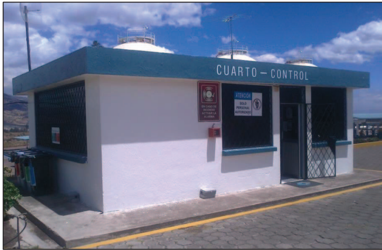
FIGURA 1-18: CUARTO DE CONTROL
