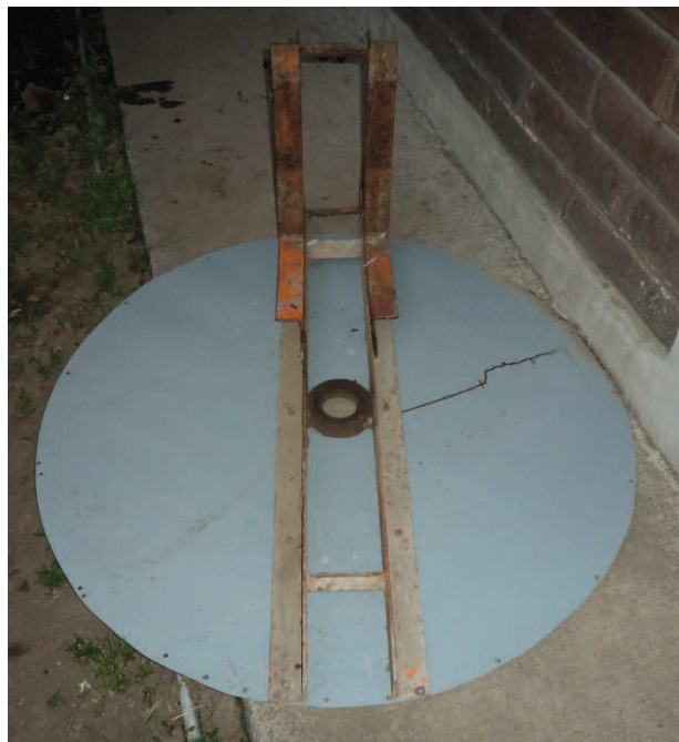
Fotografía 4.3.2 Montaje de soporte de motor.
