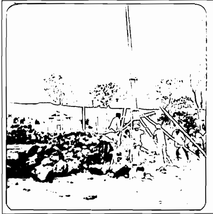
19. Alineación y aplomado del poste.
