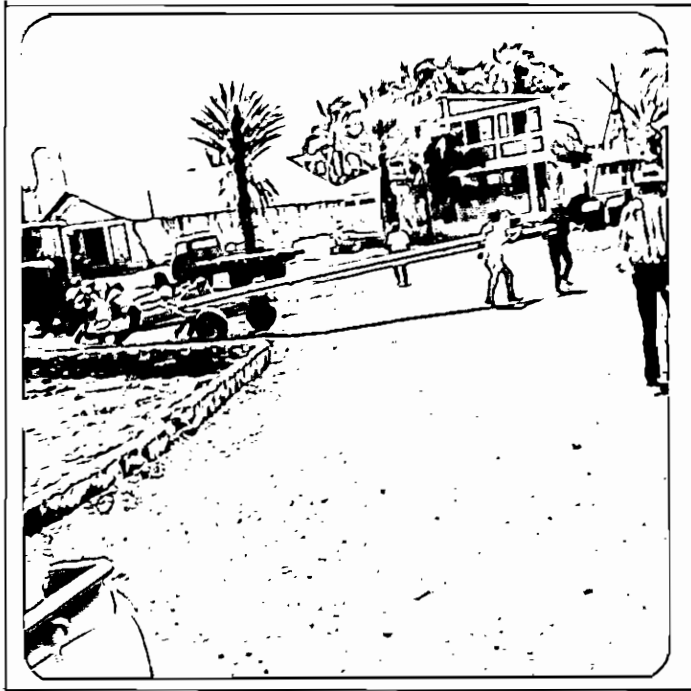
11. Asegurado el poste sobre el carretón para transportarlo al sitio.
