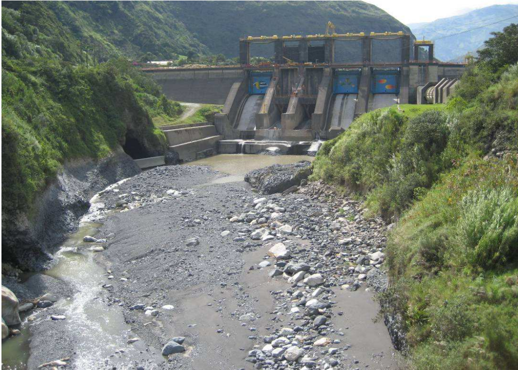
FOTOGRAFÍA 3.6: VISTA -ORIENTADA HACIA LA PRESA - DEL CAUCE DEL RÍO PASTAZA AGUAS ABAJO DE LA PRESA AGOYÁN QUE MUESTRA LA SEQUÍA A LA QUE SE ENCUENTRA SOMETIDO FRECUENTEMENTE
