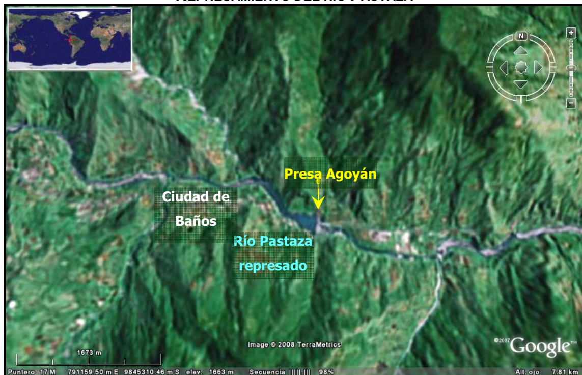
FIGURA 3.10: VISTA EN PLANTA DE LA PRESA AGOYÁN DONDE SE OBSERVA EL REPRESAMIENTO DEL RÍO PASTAZA
