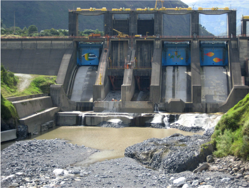
FOTOGRAFÍA 3.1: PRESA AGOYÁN CON REPRESAMIENTO DEL CAUDAL TOTAL DEL RÍO PASTAZA
