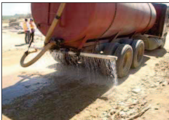
Imagen 2.3: Humedecimiento del material
