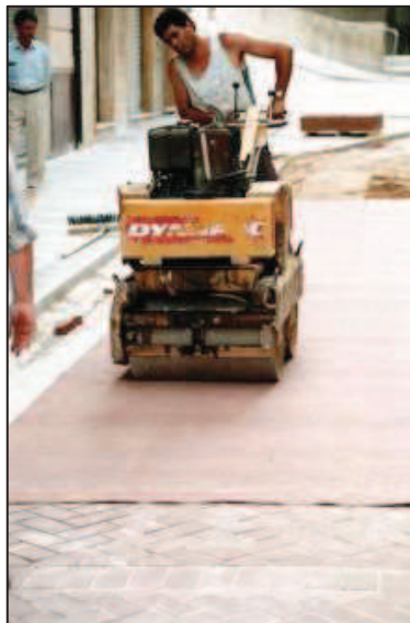
Imagen 2.9: Compactación final del adoquinado
