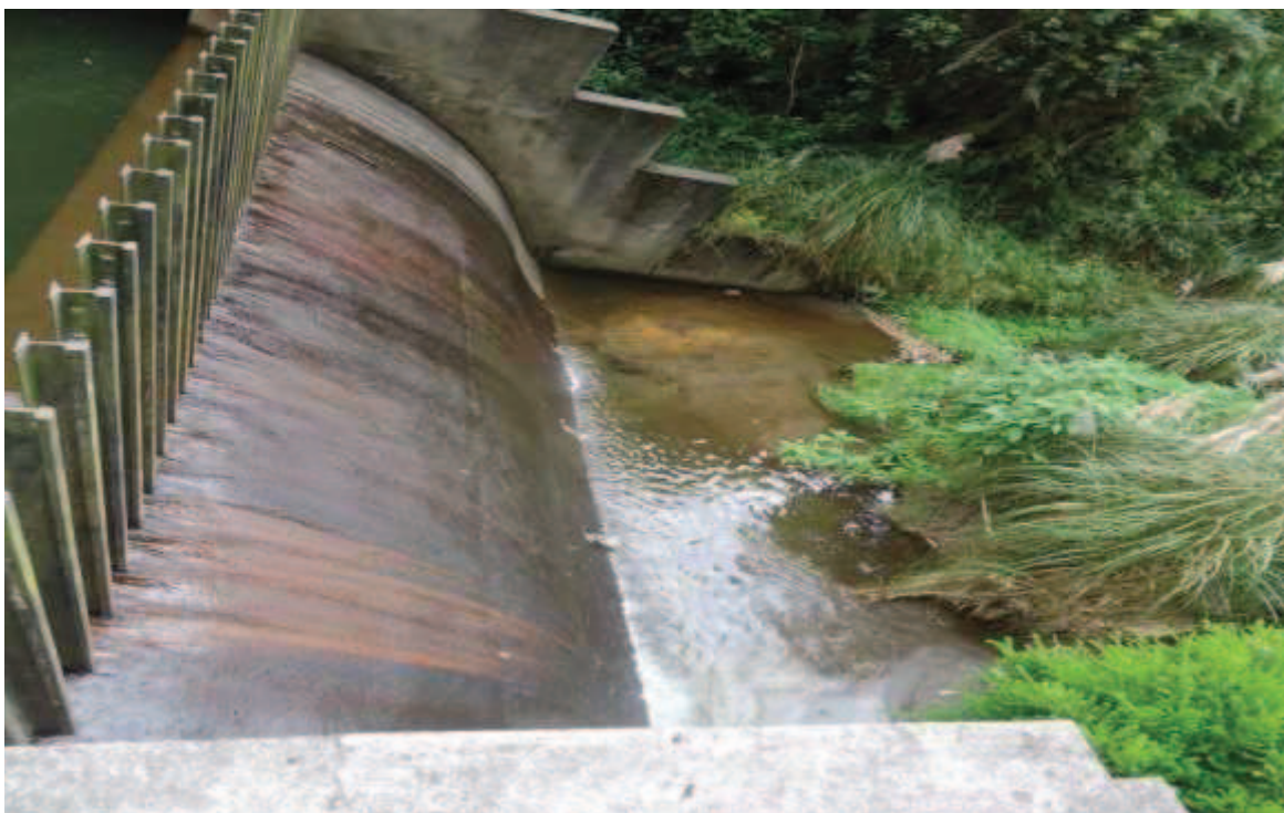
Fotografía 4.46: Dique compuesto (vista lateral)
