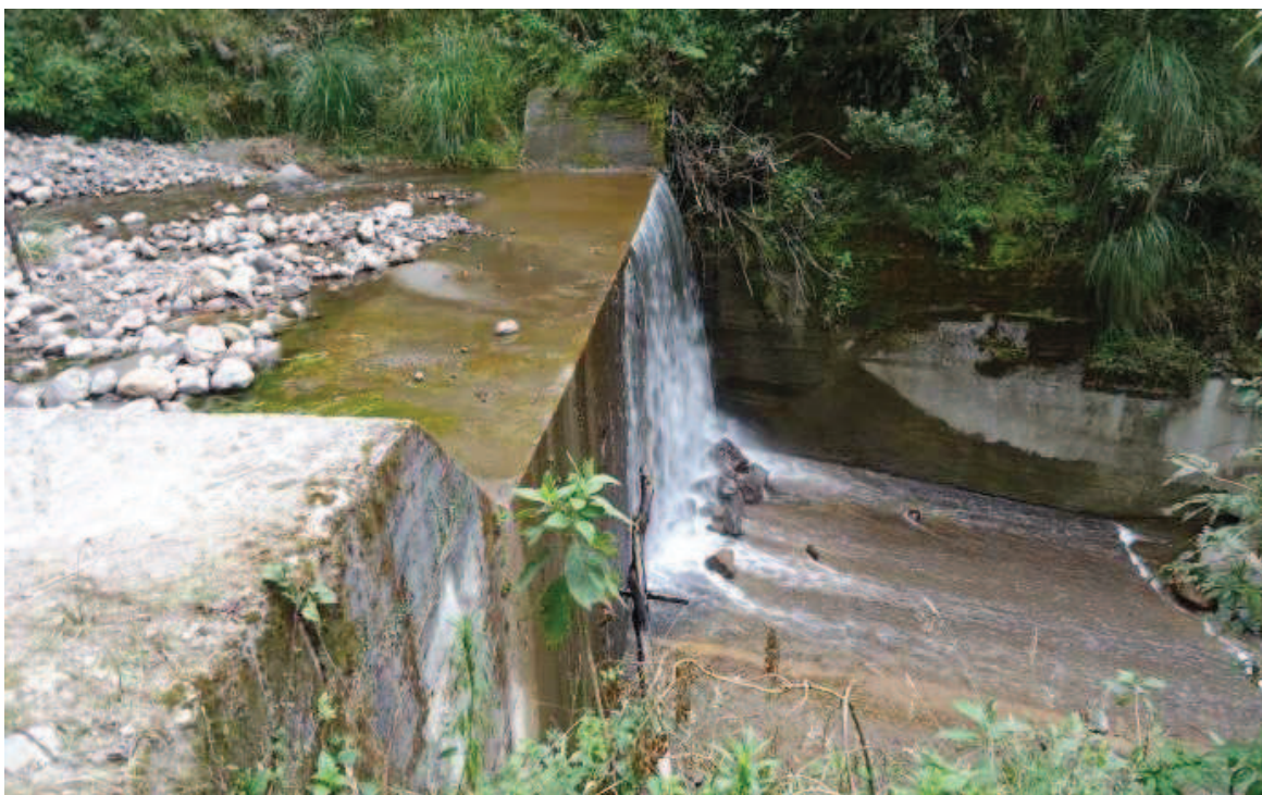
Fotografía 4.2: Dique de depositación cerrado, vista lateral (Dique 1)
