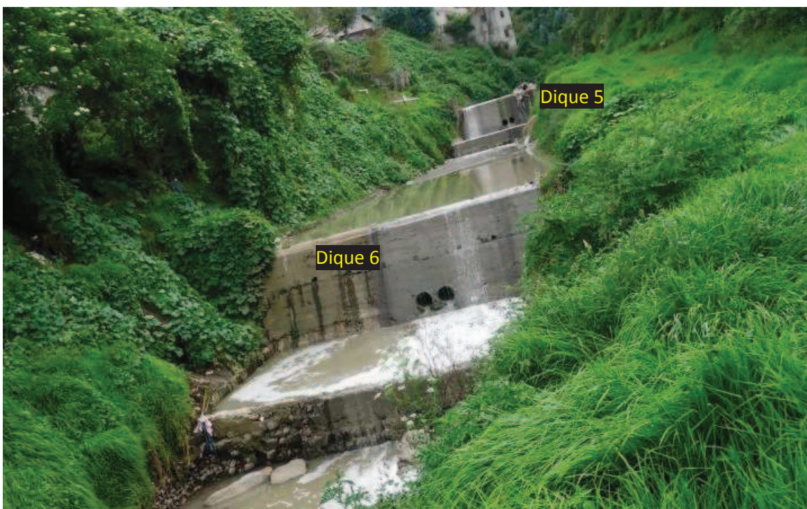
Fotografía 4.8: Dique cerrado (Diques 5 y 6)
