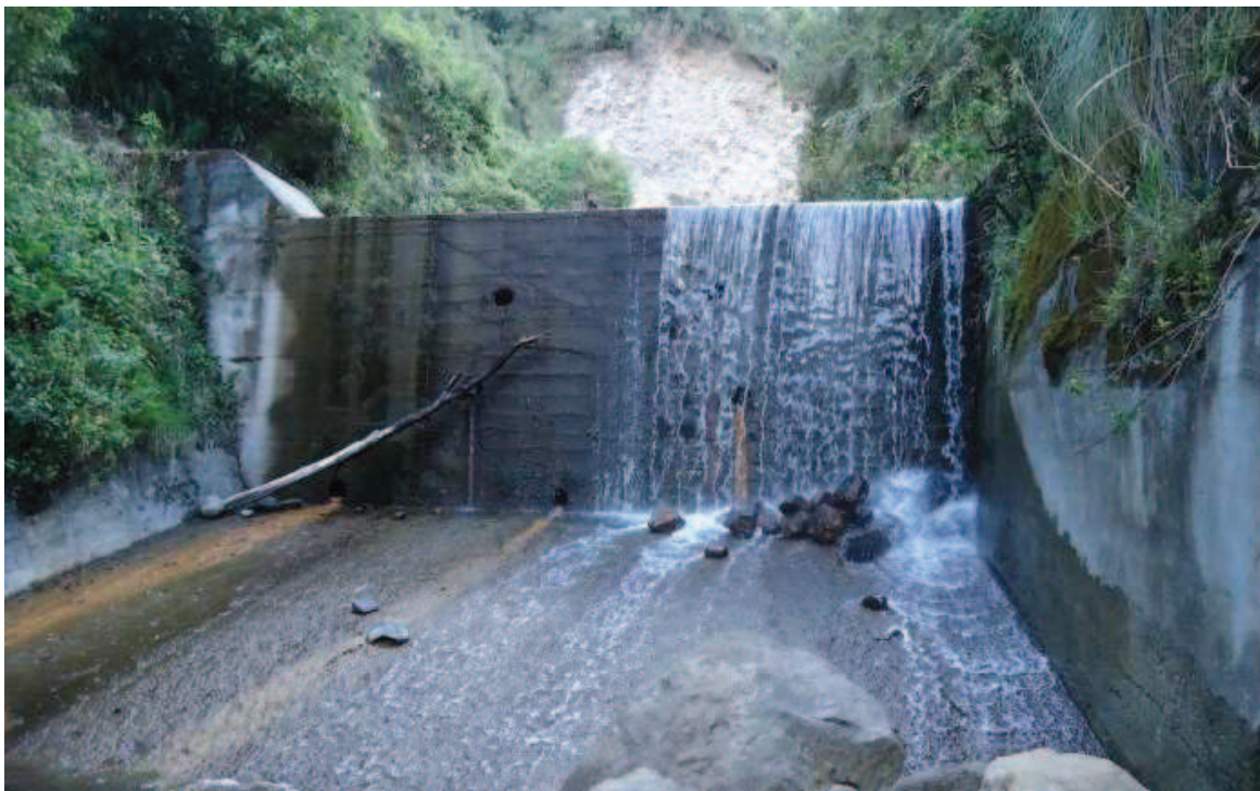
Fotografía 4.3: Dique de depositación cerrado, vista frontal (Dique 1)
