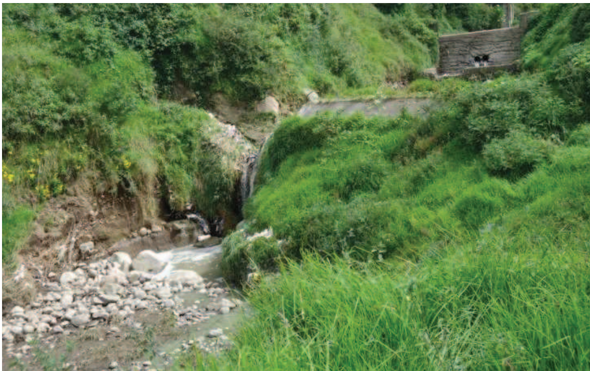
Fotografía 4.9: Dique cerrado de pared delgada, cedido (Dique 7)
