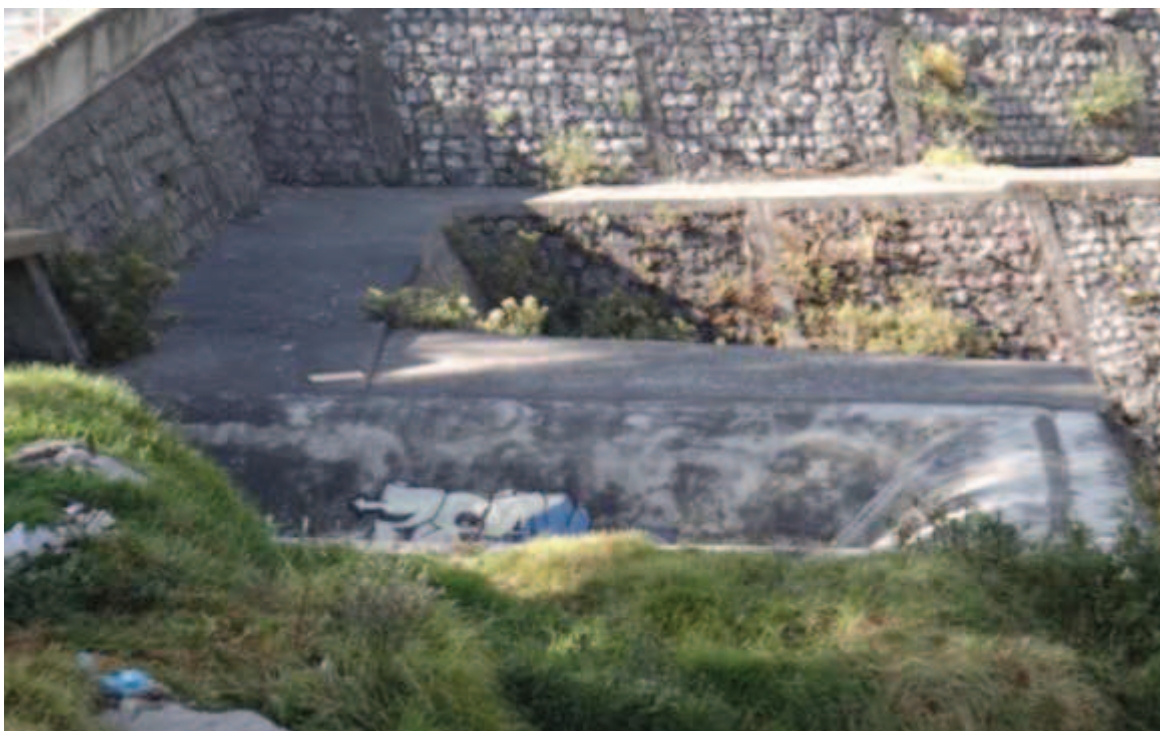
Fotografía 4.19: Vertedor de excesos, vista lateral
