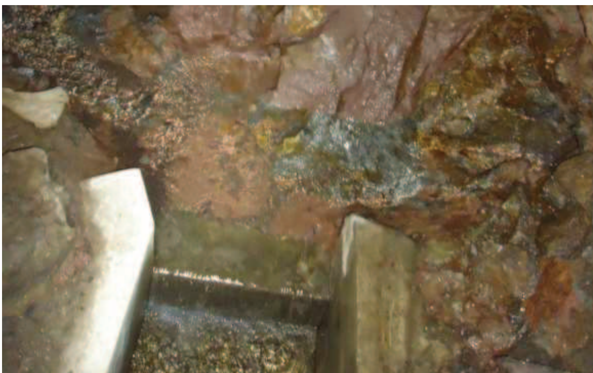
Fotografía 4.43: Captación con tanque abierto (ramal izquierdo)
