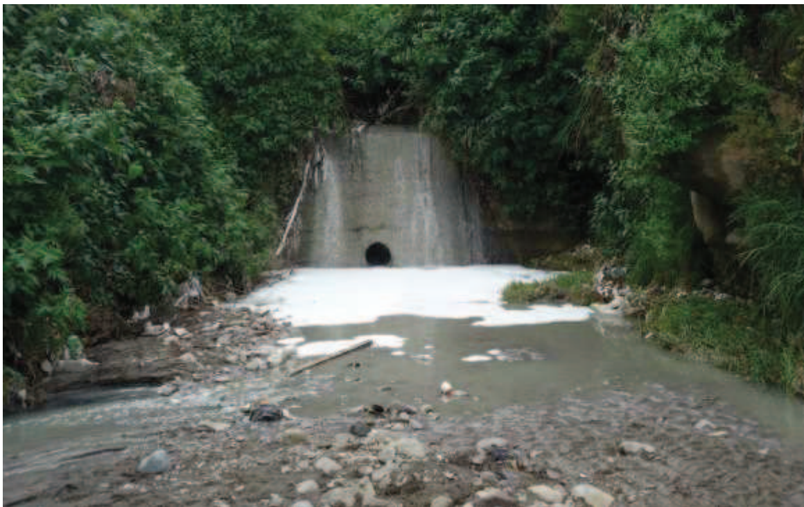
Fotografía 4.7: Dique cerrado (Dique 4)
