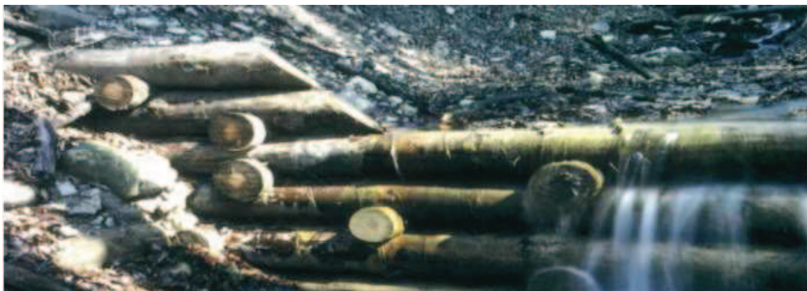
Figura 3.12: Estructura construida en madera
