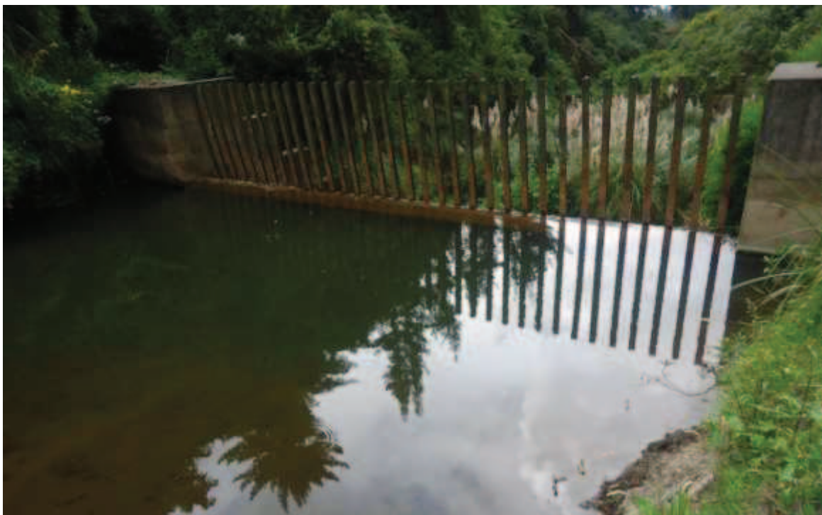
Fotografía 4.45: Dique compuesto (vista desde aguas arriba)
