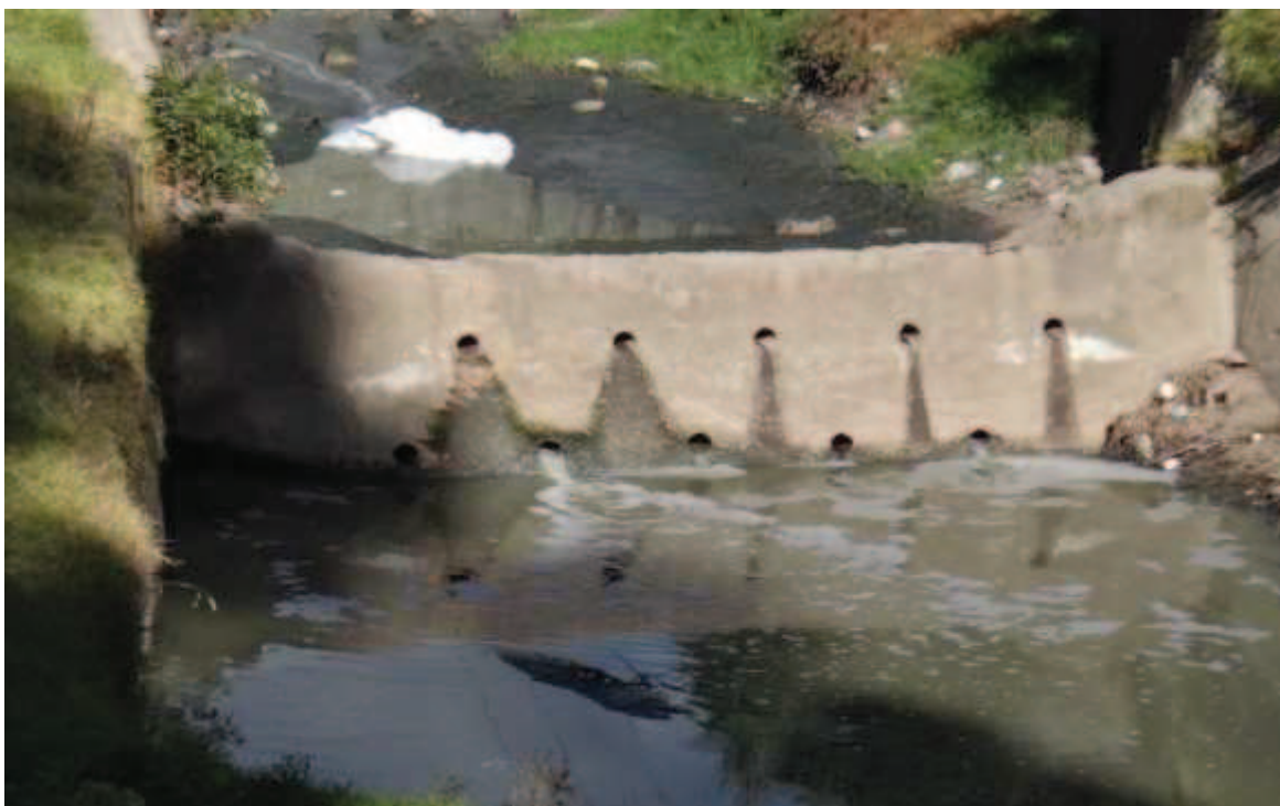
Fotografía 4.17: Dique cerrado (Dique 11)
