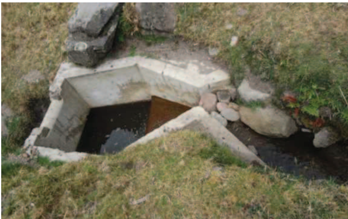
Fotografía 4.42: Captación con estrechamiento (ramal izquierdo)
