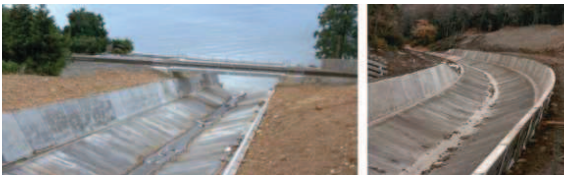
Figura 3.19: Canales de control de dirección de flujo
