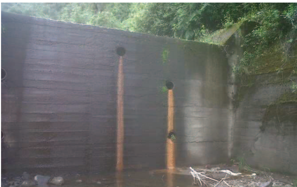
Fotografía 4.4: Dique de depositación cerrado, vista frontal (Dique 2)
