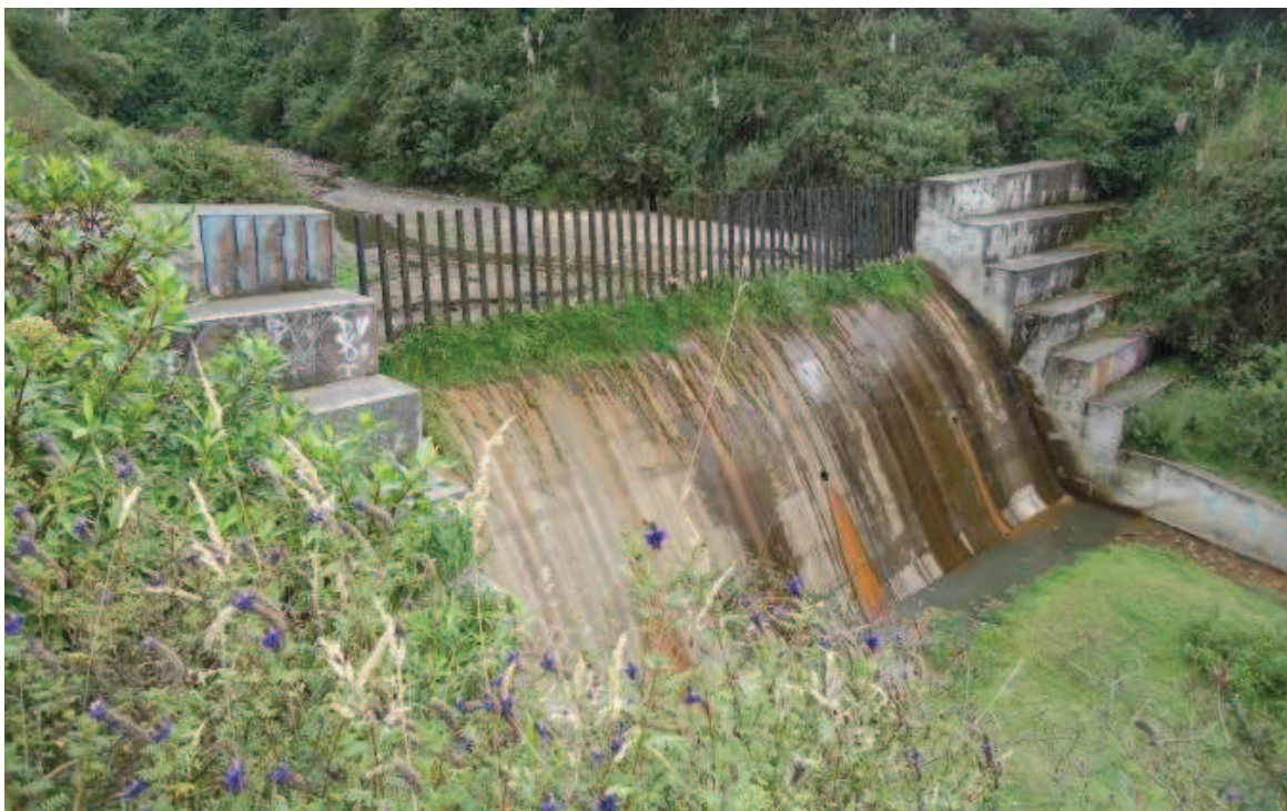
Fotografía 4.6: Dique compuesto (Dique 3)
