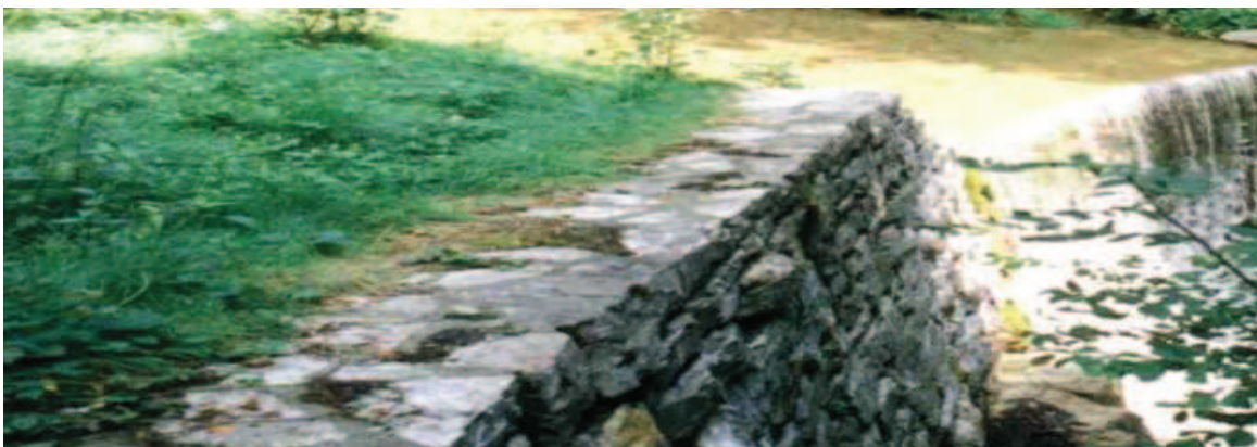
Figura 3.13: Estructura construida en mampostería de piedra
