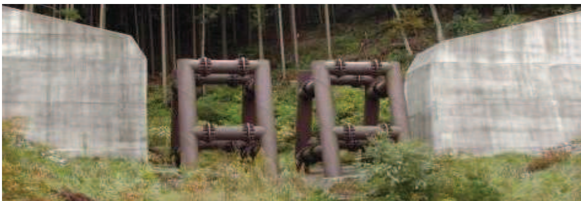
Figura 3.15: Estructura construida en hormigón y tuberías de acero
