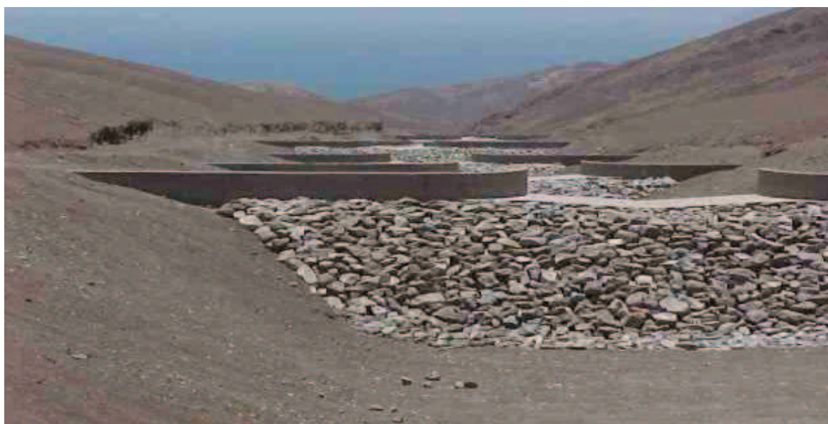
Figura 3.2: Obras de almacenamiento construidas en las cercanías de la ciudad de Antofagasta, Chile (vista hacia aguas arriba)
