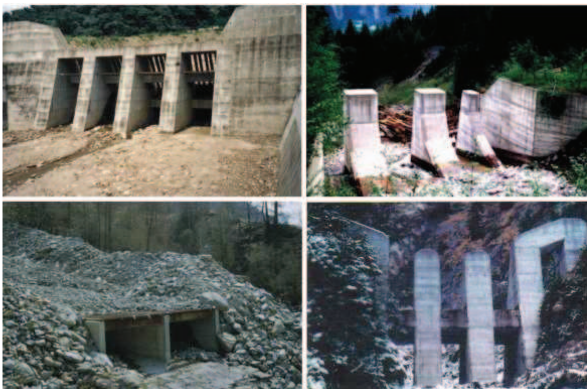
Figura 3.11: Obras de disipación de energía
