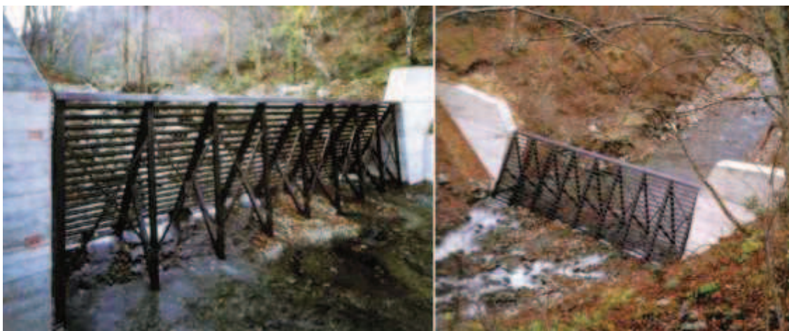
Figura 3.6: Presas de aberturas horizontal (beam-dam)
