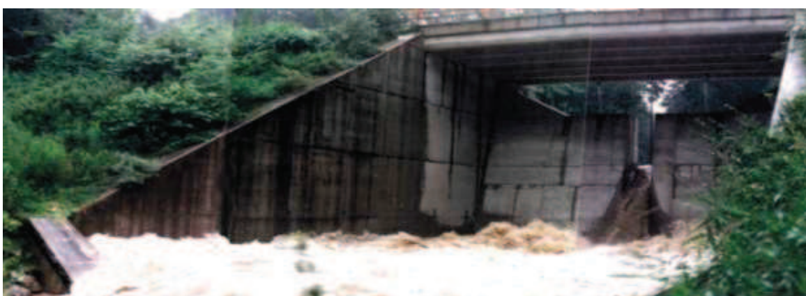
Figura 3.14: Estructura de hormigón
