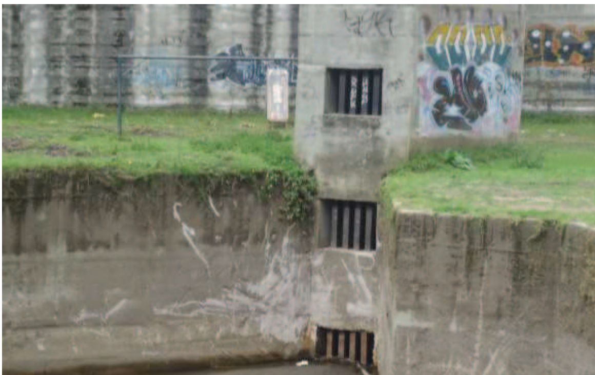
Fotografía 4.52: Torre de Captación (vista hacia aguas abajo)
