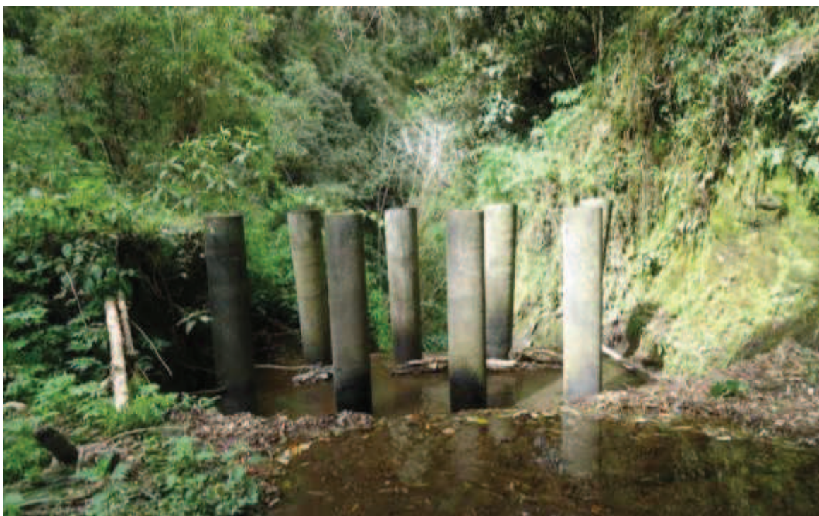
Fotografía 4.35: Dique abierto de columnas verticales con muro de gaviones
