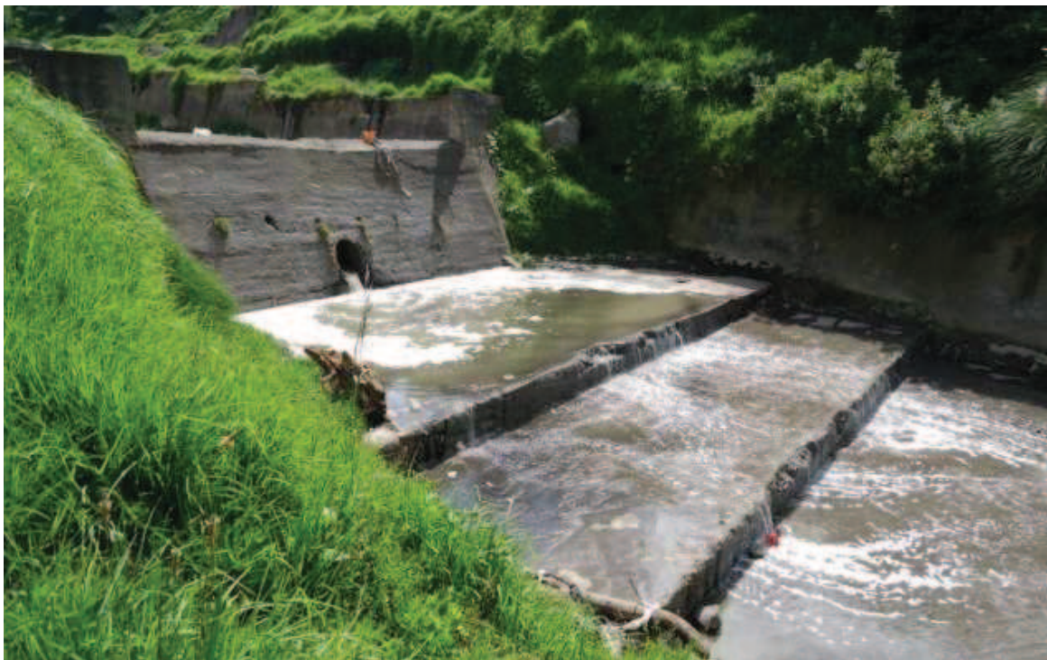
Fotografía 4.15: Dique cerrado con zampeado, aguas abajo (Dique 10)
