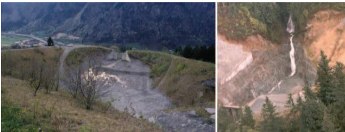
Figura 3.23: Obras de depositación
