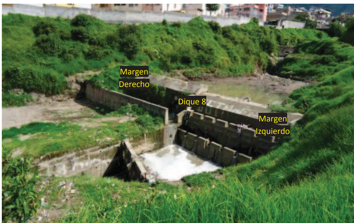
Fotografía 4.10: Dique compuesto (Dique 8)
