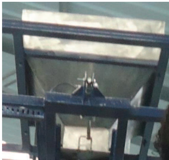
Figura 1.23 Tolva de alimentación (vista lateral inferior)
