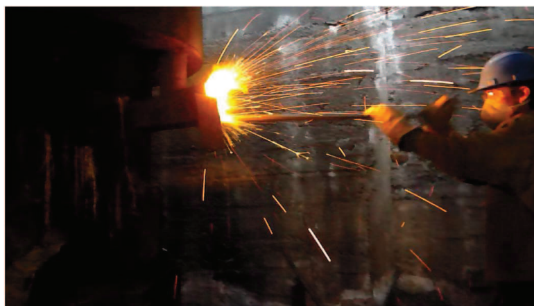
Figura 3. 32. Limpieza de las toberas.
