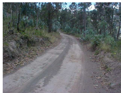
Vía de Tierra de la Zona Rural
