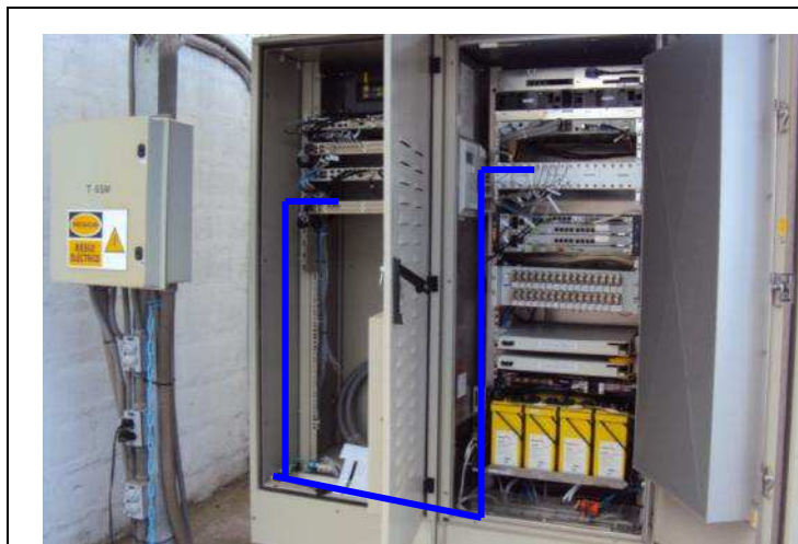
Figura 2.25 Cruzada desde DDF Conocoto Sur Dirección Conocoto Centro a DDF Conocoto Sur Dirección Santa Mónica
