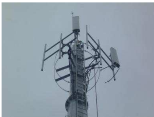
Figura 2.51 Montaje de Antenas en Monopolo
