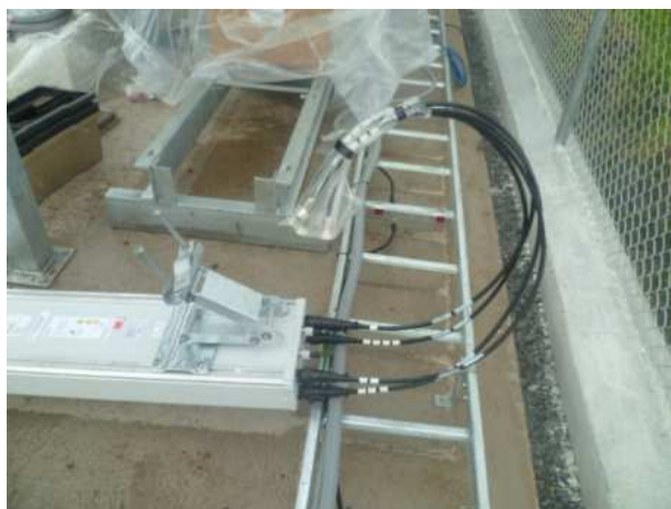
Figura 2.50 Vulcanizado, Etiquetado de Jumper de Antena
