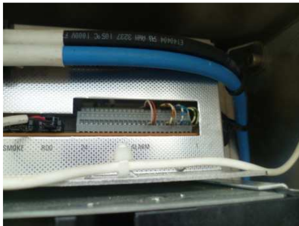
Figura 2.37 Bornera para Cableado de Alarmas Externas
