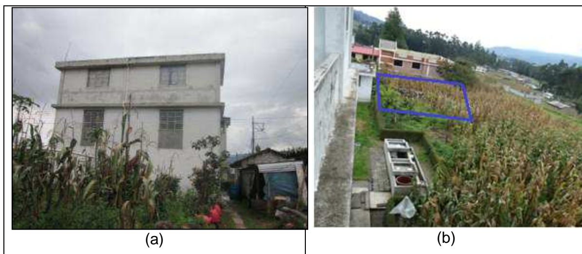
Figura 2.4 (a) Acceso a la RBS, (b) Espacio donde se ubicará la RBS
