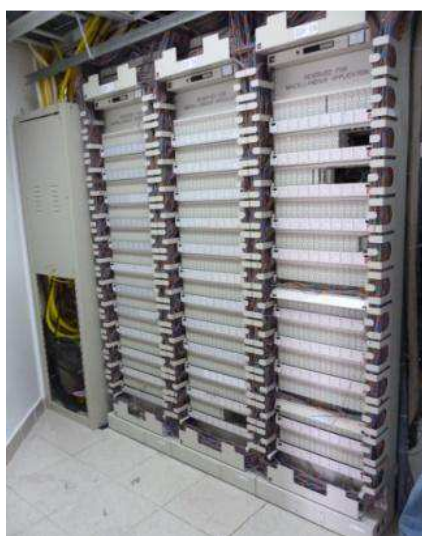
Figura 2.29 Entorchados en la Central De Otecel para E1 de Santa Mónica
