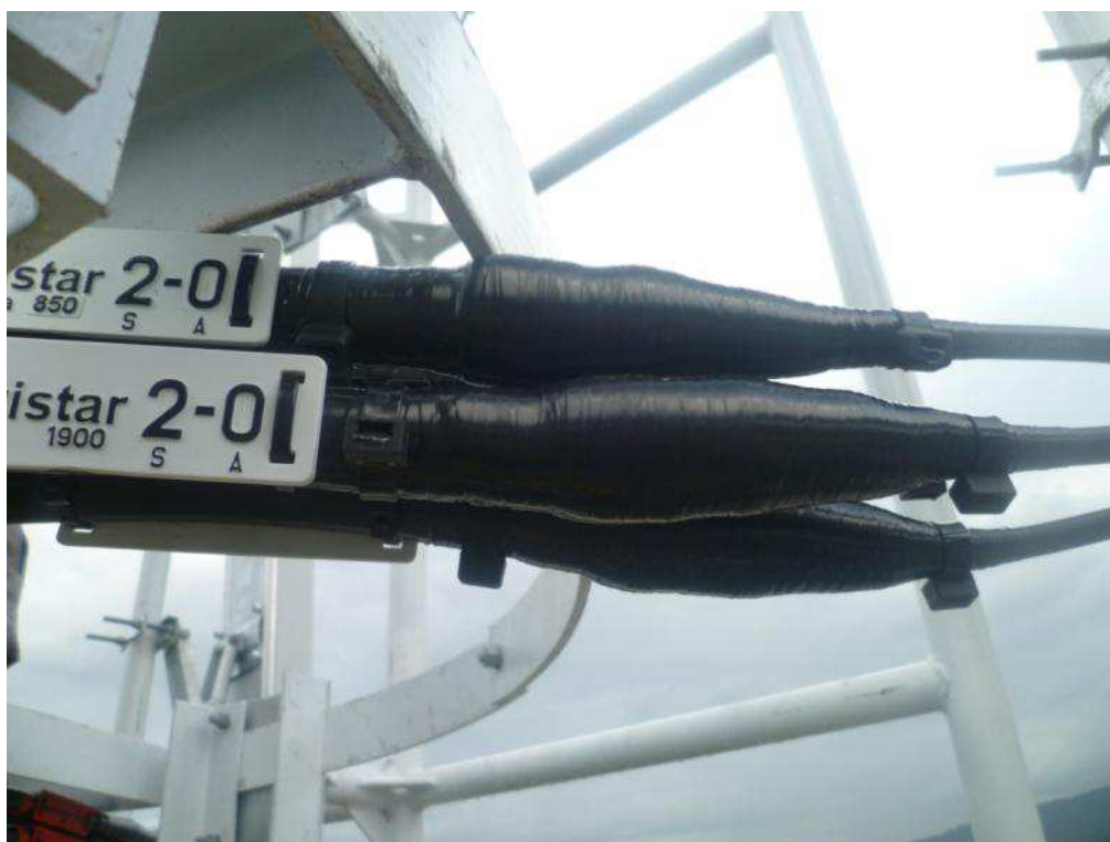
Figura 4.15 Vulcanizado en la unión Feeder – Jumper
