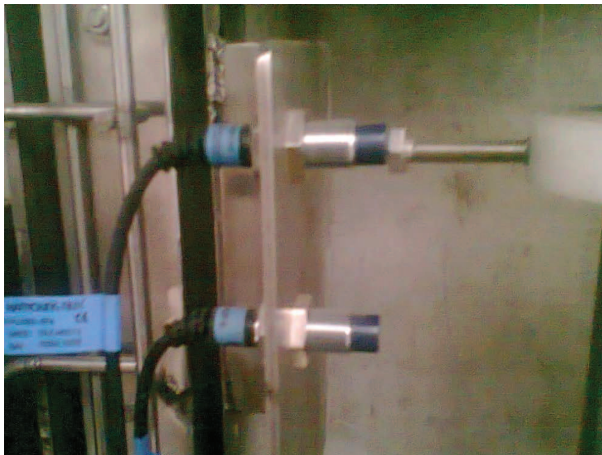
Figura 2.8 Sensores inductivos.
