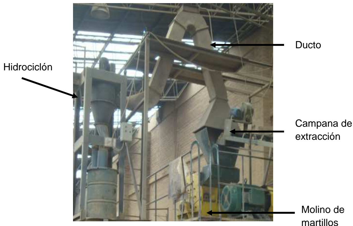
Figura 1. 3. Sistema de evacuación del material particulado
