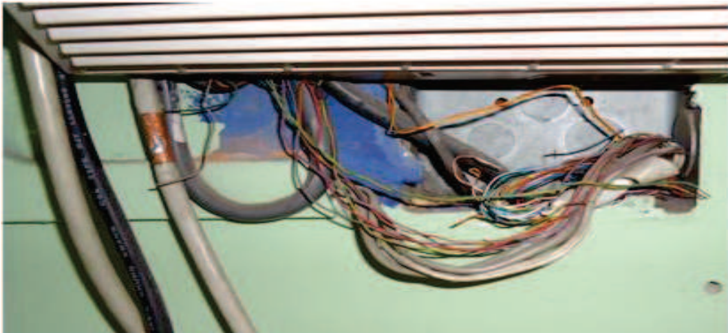
Figura 2-19 Acometida de troncales telefónicas
