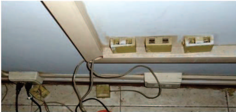
Figura 2-11 Salidas de telecomunicaciones
