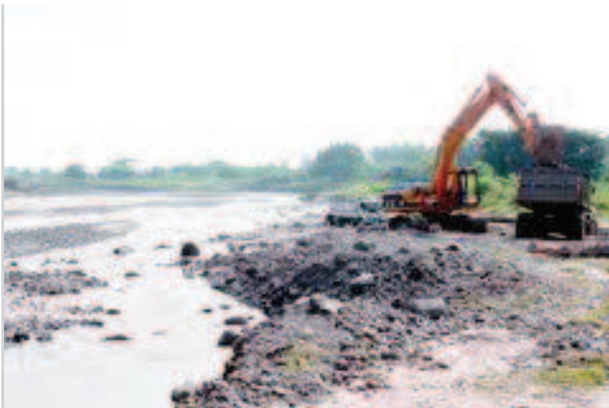
Figura 1. 20: Extracción de la piedra de río.
