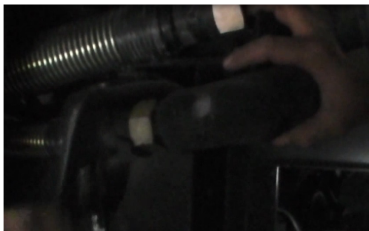
Fig. 46.- Acoplamiento de mangueras a las cañerías de cobre Archivo fotográfico personal
