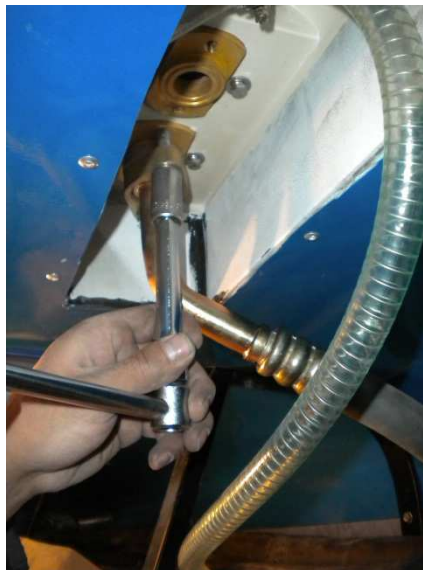
Fig. 48.- Aseguramiento de las mangueras a los acoples del equipo de techo Archivo fotográfico personal
