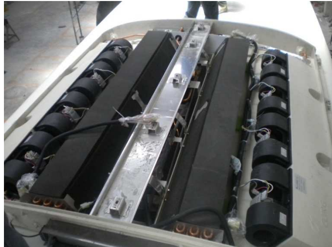
Fig. 24.- Elevación del equipo evaporador Archivo fotográfico personal
