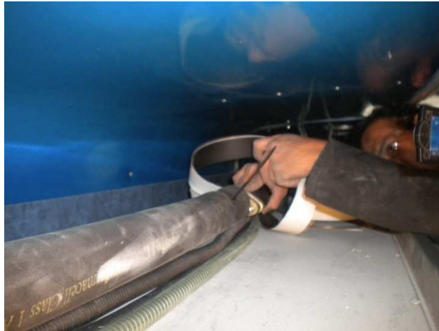
Fig. 47.- Forrado con cinta rubatex los acoplamientos Archivo fotográfico personal
