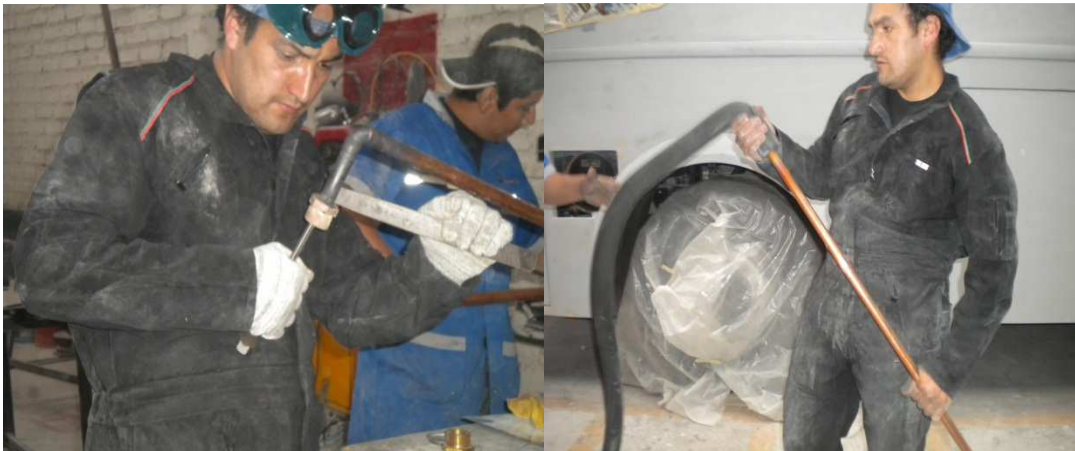
Fig. 35.- Verificación de las sueldas Archivo fotográfico personal
