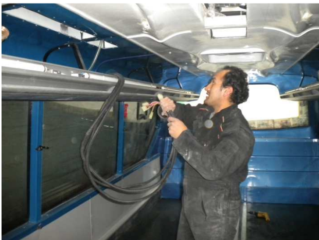
Fig. 52.- Instalación de conjunto de cables eléctricos Archivo fotográfico personal
