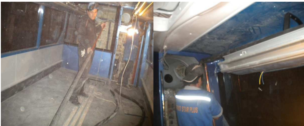
Fig. 37.- Instalación de las cañerías en la carrocería Archivo fotográfico personal
