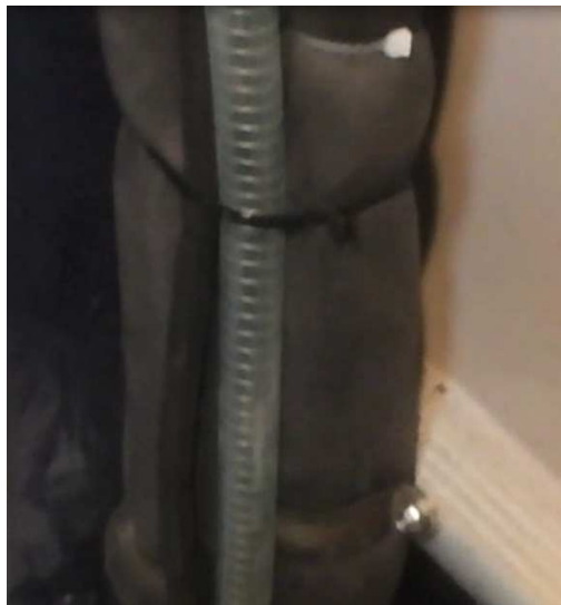
Fig. 39.- Aseguramiento de las cañerías y amarre de manguera de desagüe Archivo fotográfico personal
