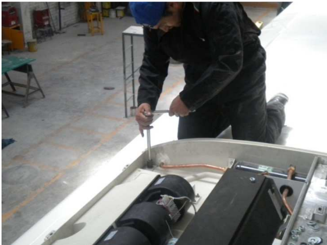
Fig. 25.- Aseguramiento del equipo evaporador Archivo fotográfico personal
