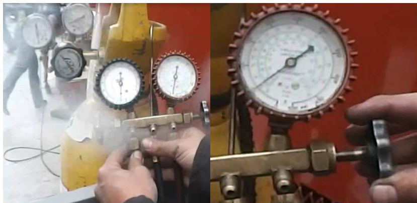
Fig. 72.- Purga de manguera y carga de refrigerante líquido por el lado de alta presión Archivo fotográfico personal
