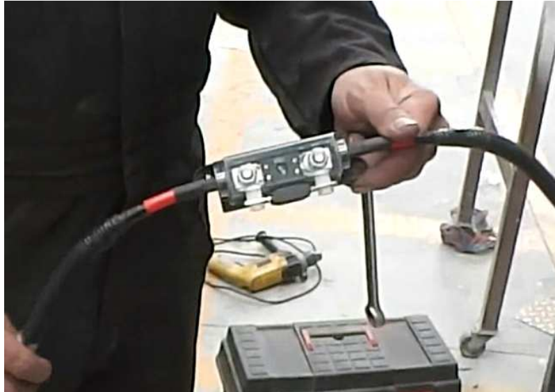
Fig. 50.- Instalação de protector eléctrico (150 A) Archivo fotográfico personal
