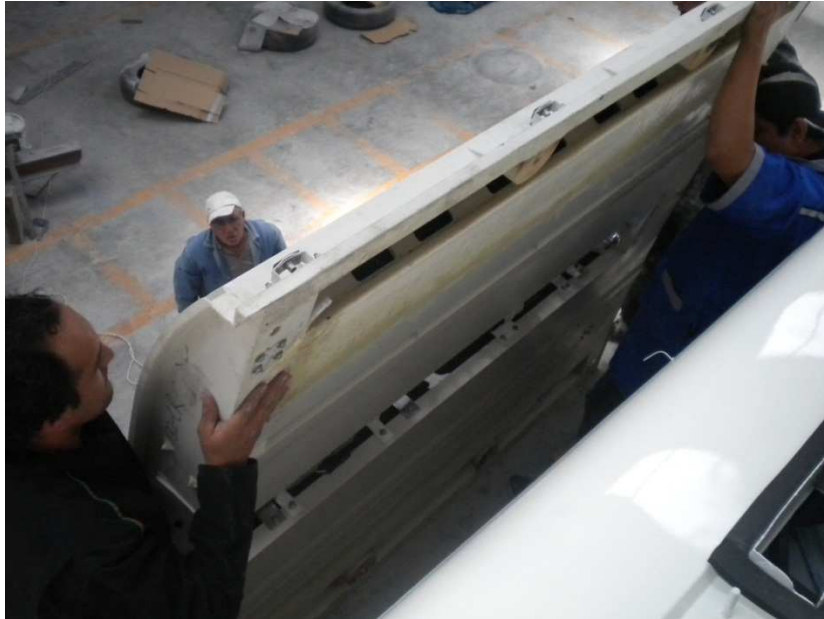
Fig. 22.- Elevación del equipo evaporador Archivo fotográfico personal
