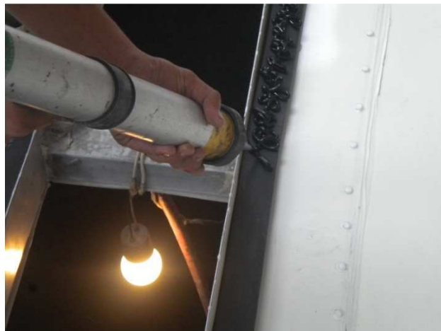
Fig. 20.- Aplicación de sikaflex Archivo fotográfico personal
