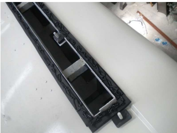
Fig. 21.- Aplicado sikaflex y cauchos base para pernos Archivo fotográfico personal
