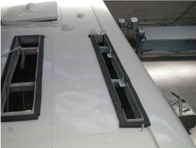
Fig. 19.- Orificios de techo listos para montaje de evaporador Archivo fotográfico personal
