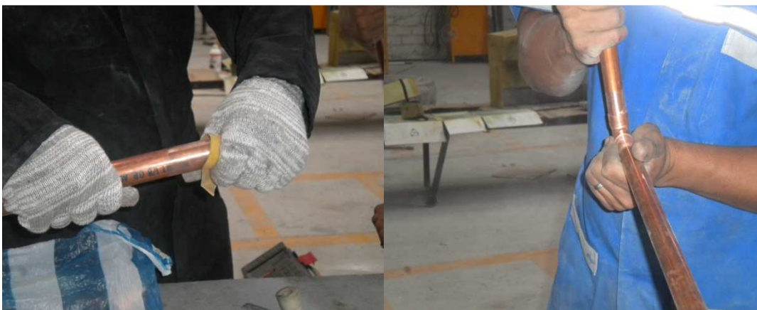
Fig. 31.- Preparación de las superficies y juntas para soldar Archivo fotográfico personal
