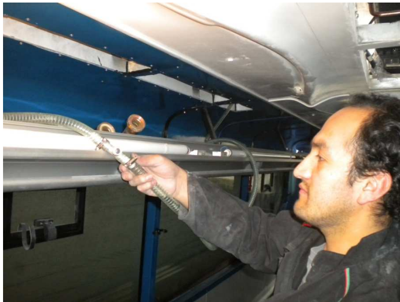
Fig. 40.- Instalación de manguera de desagüe Archivo fotográfico personal
