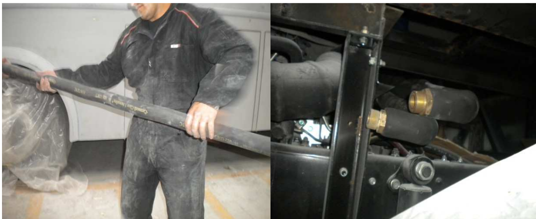
Fig. 36.- Protección de cañerías con gomas de rubatex Archivo fotográfico personal
