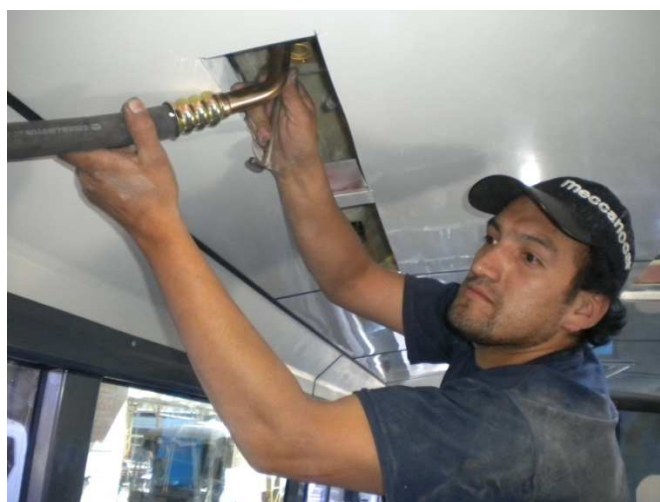
Fig. 42.- Instalación de mangueras Archivo fotográfico personal
