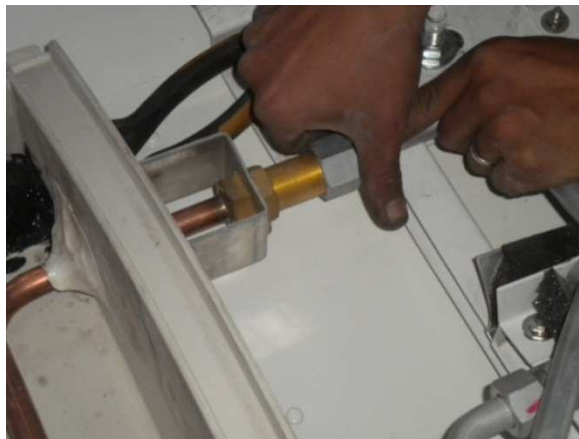
Fig. 28.- Acoplamiento equipo evaporador-condensador Archivo fotográfico personal
