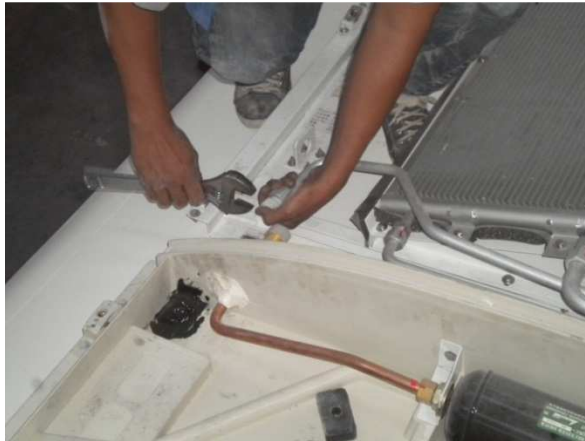
Fig. 27.- Retiro de tapones de los acoples del equipo Archivo fotográfico personal
