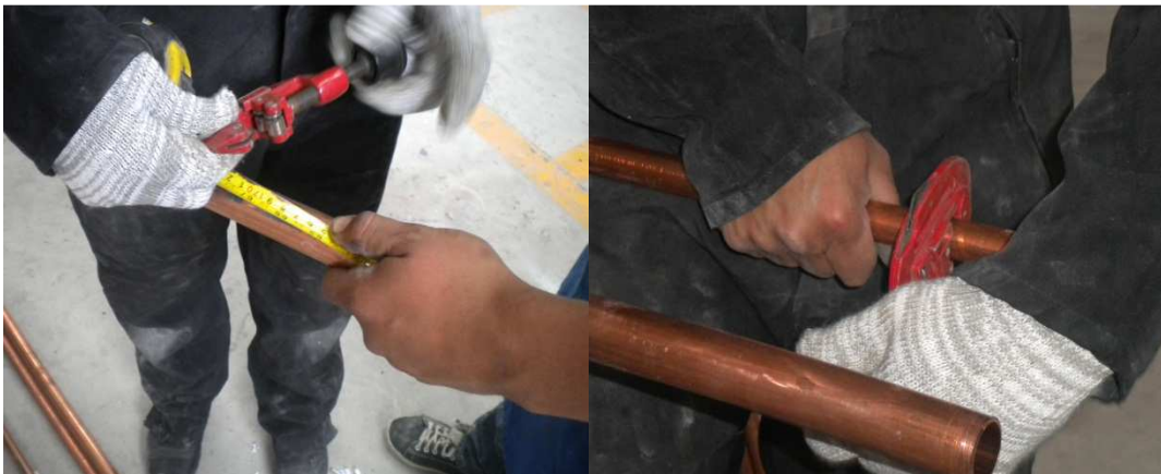
Fig. 30.- Toma de medidas y corte de los tubos de cobre Archivo fotográfico personal
