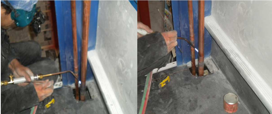
Fig. 33.- Soldaduras en lugar de instalación Archivo fotográfico personal
