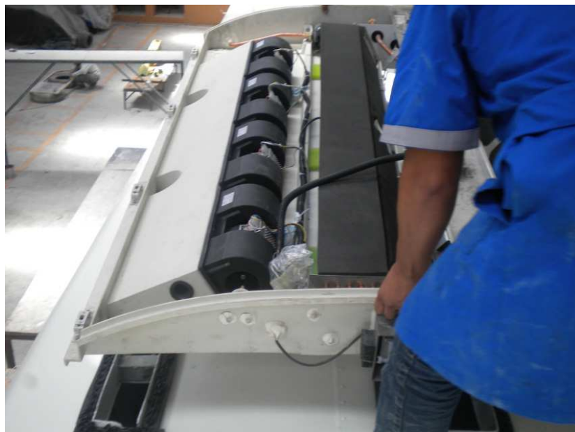
Fig. 23.- Montaje del equipo evaporador Archivo fotográfico personal
