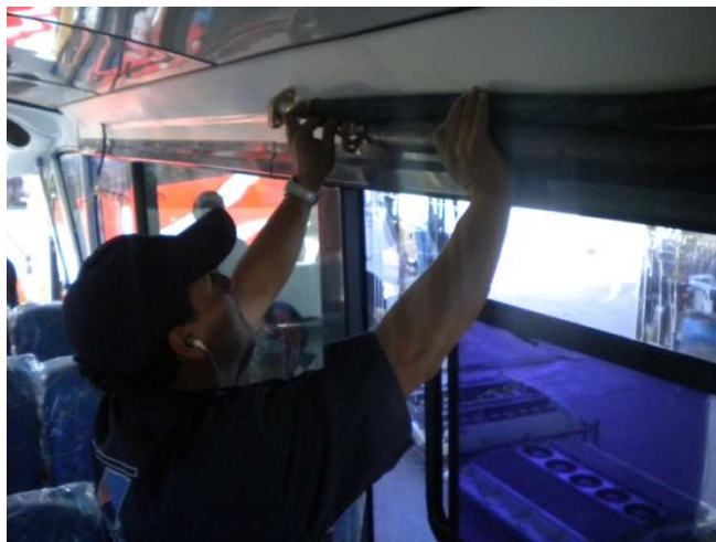
Fig. 41.- Medición de las mangueras Archivo fotográfico personal
