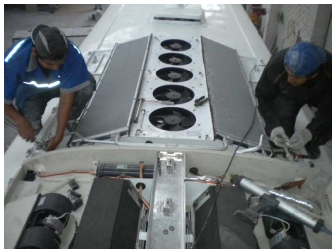
Fig. 26.- Montaje y aseguramiento del equipo condensador Archivo fotográfico personal
