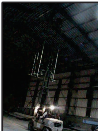
Fig.6.8 Instalación de luminarias a 12 m de altura.
