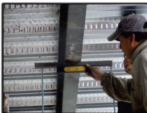
Fig.6.11 Base soldada a Viga Metálica para instalación de luminarias
