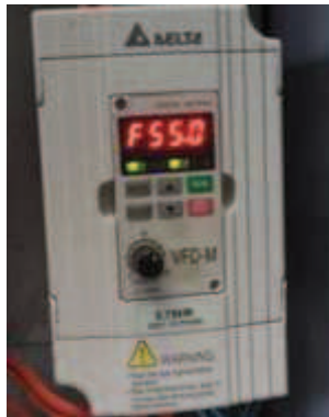
Figura 4.3 Variador de Frecuencia
