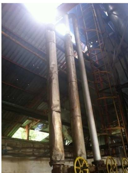
Figura 3-9 Tuberías Cubiertas por material Aislante
