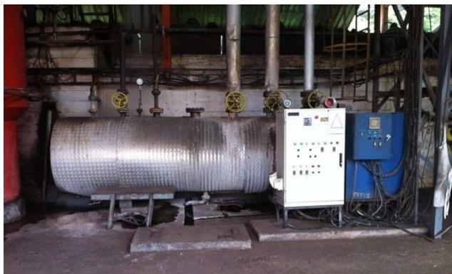
Figura 1-15 Sistema de Distribución de vapor
