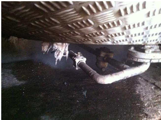
Figura 3-4 Trampa de Vapor Termostática Fabrica PALCIEN
