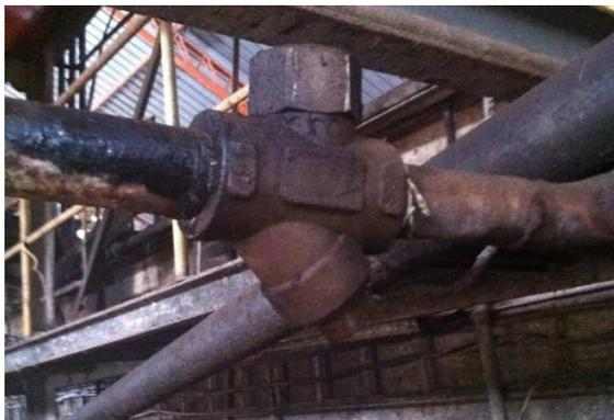
Figura 3-2 Trampa de Vapor Termostática Fabrica PALCIEN
