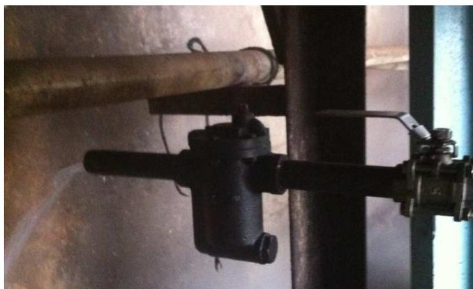
Figura 3-3 Trampa de Vapor Termostática Fabrica PALCIEN
