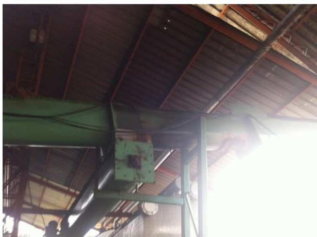
Figura 3-7 Tuberías Cubiertas por material Aislante
