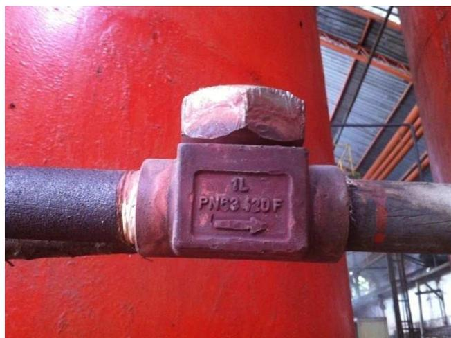
Figura 3-5 Trampa de Vapor Termostática Fabrica PALCIEN
