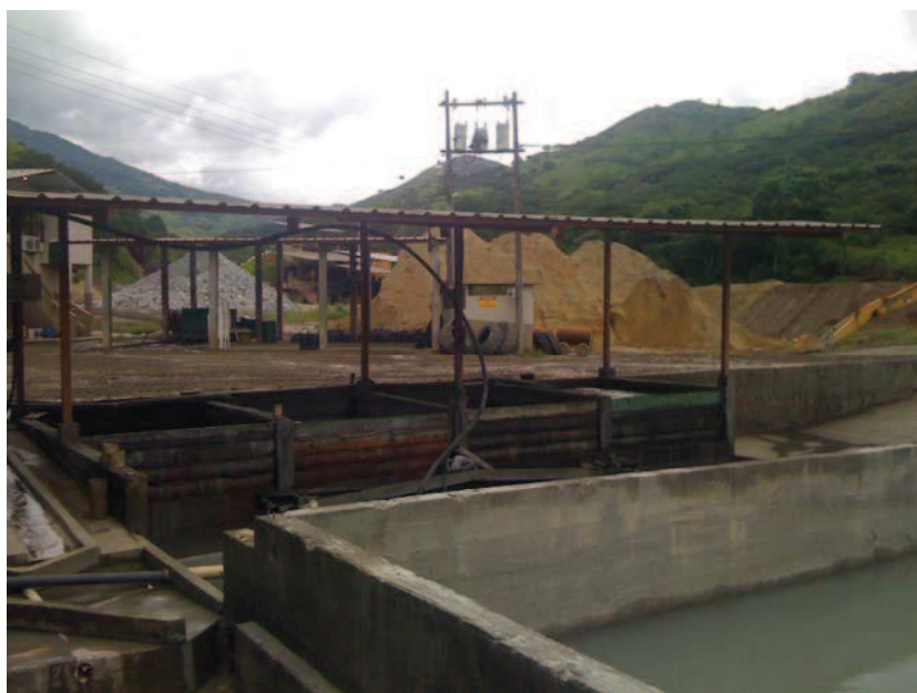
Figura 1.21 Piscinas de decantación de concentrados de flotación
