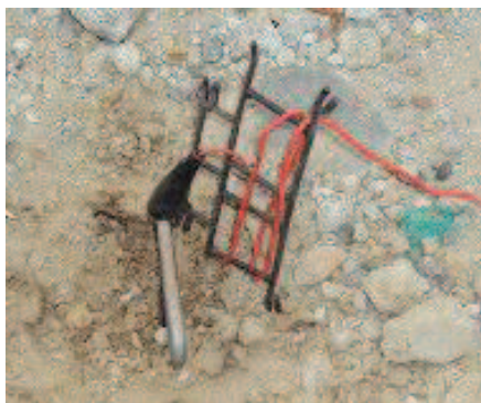
Figura 36 Pica de prueba instalada
