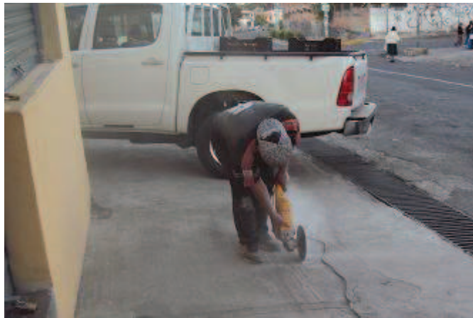
Figura 40 Corte de la Cimentación para el Sistema de Puesta a Tierra.
