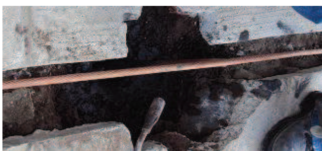
Figura 49 Tendido del cable para el sistema de puesta a tierra
