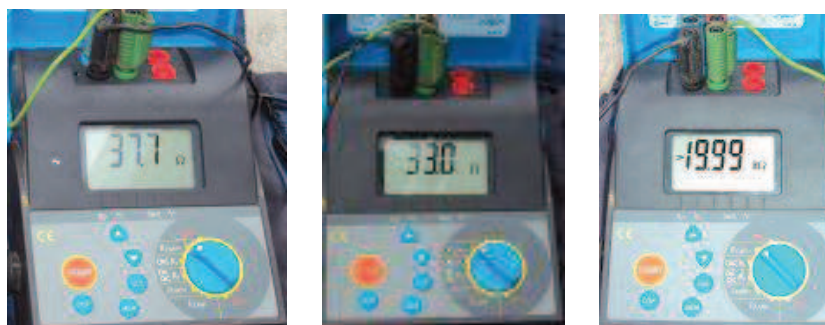
Figura 45 Medición previa de los electrodos de puesta a tierra
