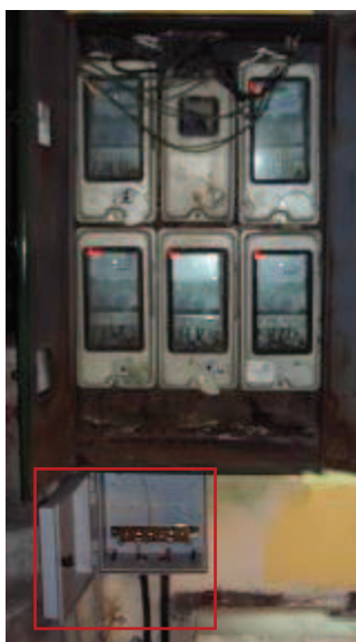
Figura 56 Instalación de la Caja de Distribución.
