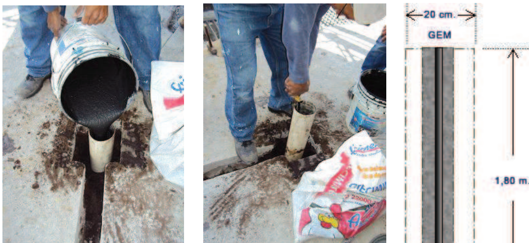
Figura 48 Aplicación del tratamiento químico con GEM
