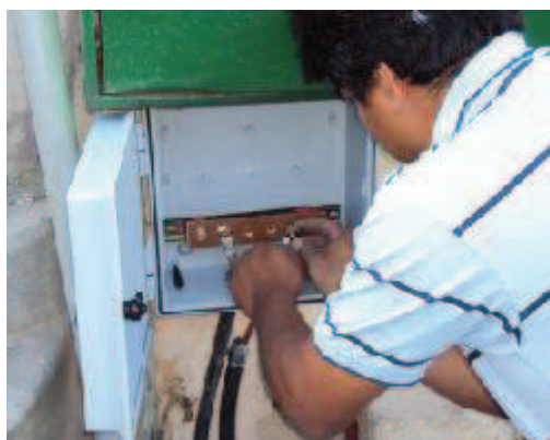
Figura 60 Conexión del cable a la placa.
