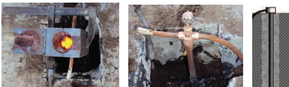
Figura 54 Fundición Exotérmica del cable con el electrodo.
