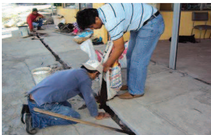
Figura 42 Colocación de Limo para la Instalación del Sistema de Puesta a Tierra
