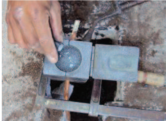
Figura 53 Colocación de pólvora de ignición
