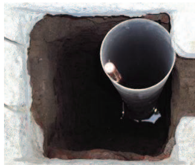
Figura 47 Ubicación de tubo PVC para el tratamiento químico con GEM
