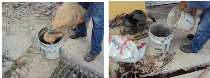
Figura 46 Preparación del compuesto químico GEM.
