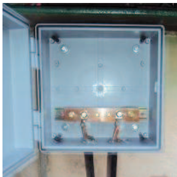
Figura 58 Placa de cobre instalada
