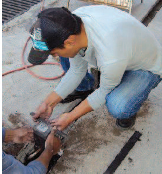
Figura 51 Instalación del molde de grafito
