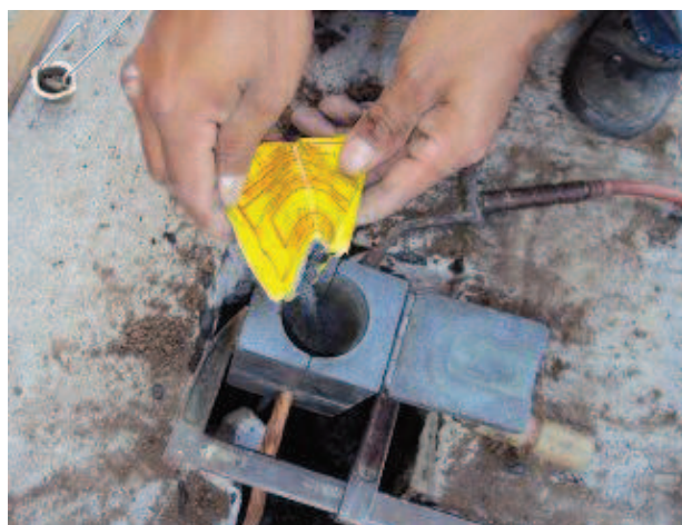
Figura 52 Ubicación de la soldadura en el molde.
