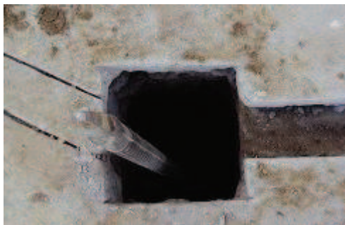
Figura 41 Excavación de las secciones para la instalación de Electroodos.
