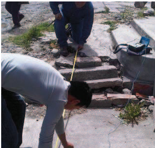
Figura 35 Proceso de medición de distancia entre picas
