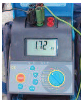
Figura 61 Medición final del Nuevo sistema de Puesta a Tierra
