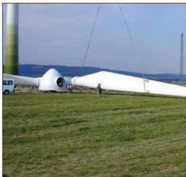
Gráfico 4-16: Ensamblaje de las palas en el buje del rotor.
