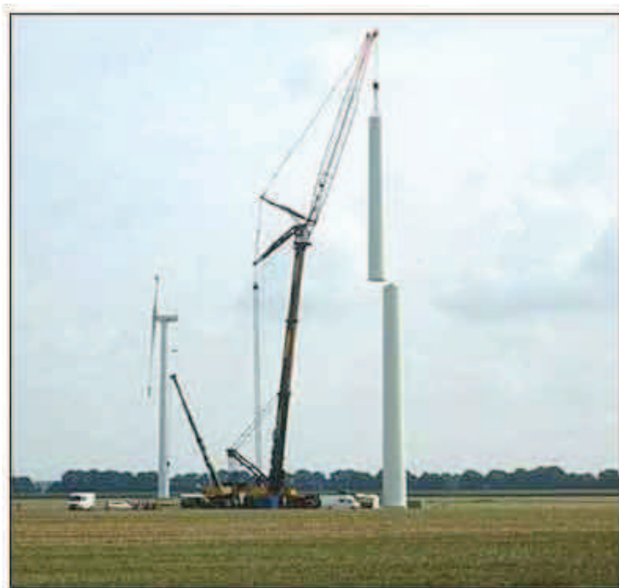
Gráfico 4-15: Momento del izado de las partes de la torre de un aerogenerador.
