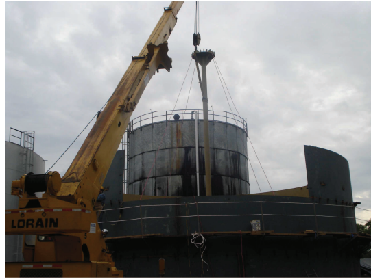
Figura 5. 6. Montaje de columna central
