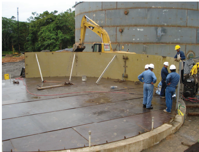
Figura 5. 8. Soldadura de las planchas del primer anillo al anillo del fondo del tanque
