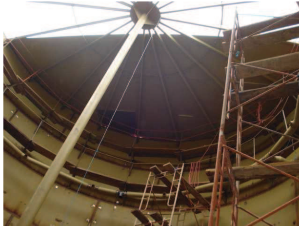
Figura 5. 12. Vigas ensambladas a la columna central
