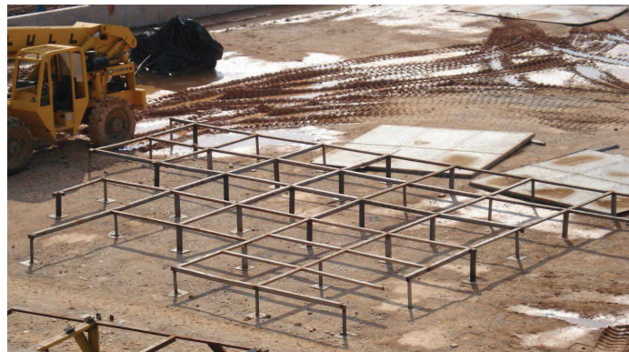
Figura 5. 13. Mesas de trabajo para prefabricado de bafles
