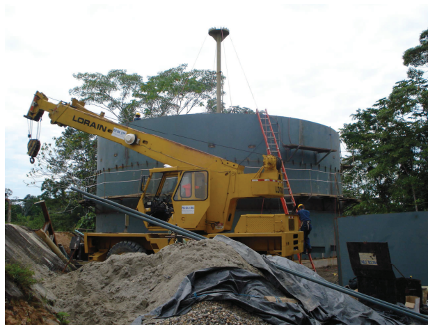
Figura 5. 7. Columna central montada y sujeta con cables tensados
