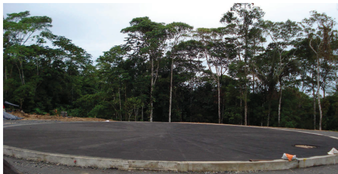
Figura 5. 1. Vista del anillo de hormigón previo al montaje de un tanque Fuente: PEC Cía. Ltda., 2013
