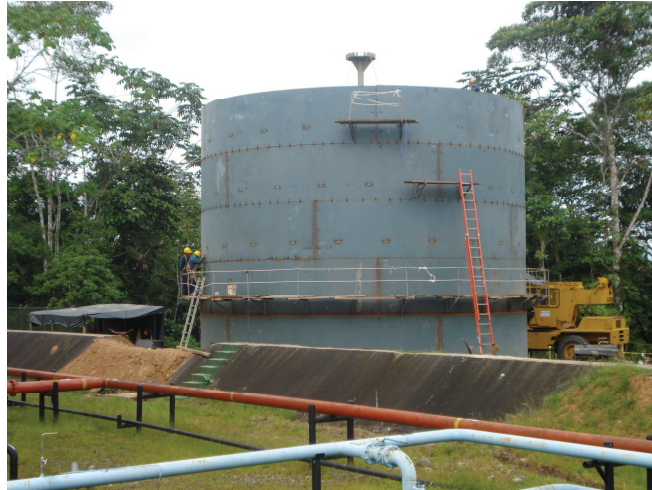
Figura 5. 11. Cuerpo del tanque montado
