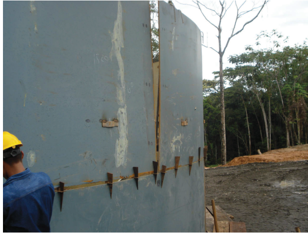
Figura 5. 9. Planchas utilizadas para centrar las planchas del cuerpo del tanque
