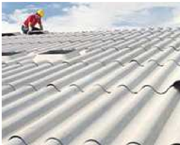
Figura 1. 1 Cubiertas de fibrocemento
