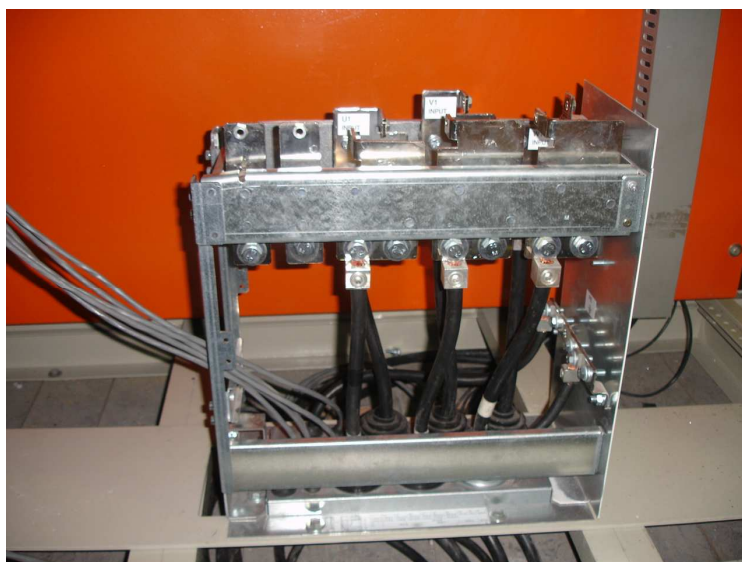
Figura 5. 6 Montaje del pedestal del variador de velocidad
