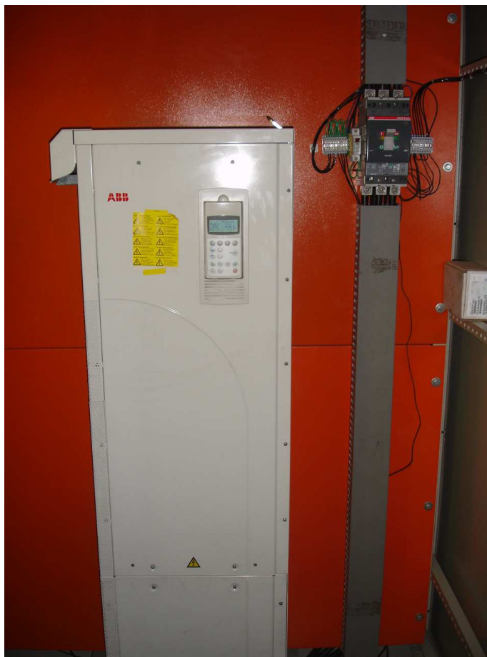
Figura 5. 1 Montaje de los equipos dentro del armario de fuerza
