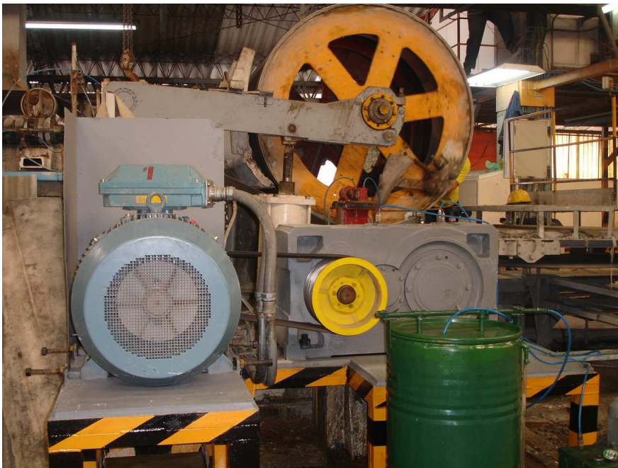
Figura 2. 7 Nuevo motor y caja reductora
