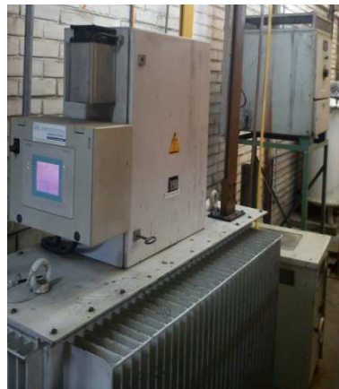
Figura 1.23 Rectificadores para las cubas de níquel y cromo 2 .
