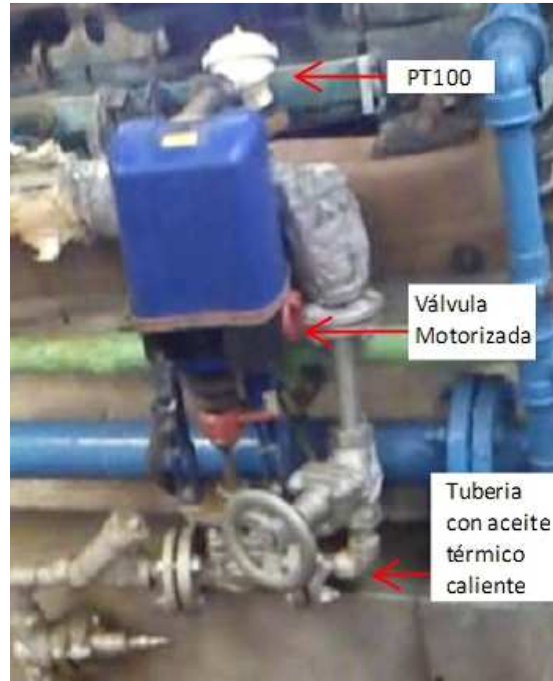
Figura 4.16 Sistema de calentamiento. 2
