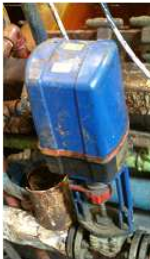
Figura 2.17 Válvula motorizada con fines de carrera 2 .
