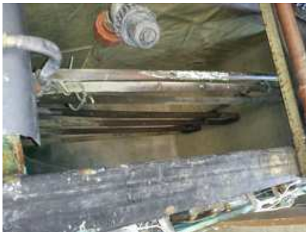
Figura 1.15 Serpentín para calentamiento 2 .
