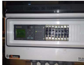
Figura 1.22 Control de tiempos para el proceso de galvanoplastia 2 .
