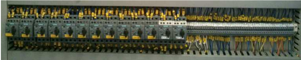
Figura 4.5 Guardamotores y borneras E/S. 21
