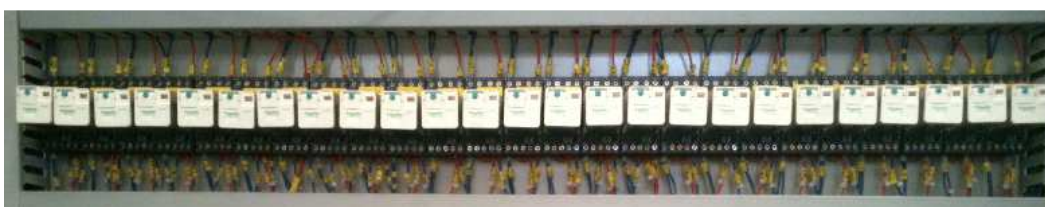
Figura 4.3 Sección de relés. 21
