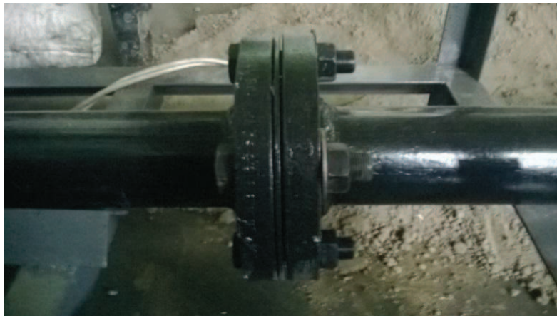
Figura 4-31 Bidas y placa orificio acopladas mediante pernos
