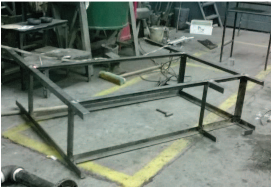
Figura 4-25 Montaje de la estructura metálica
