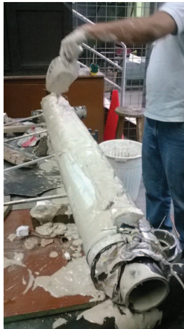
Figura 4-21 Colado de mezcla adherente
