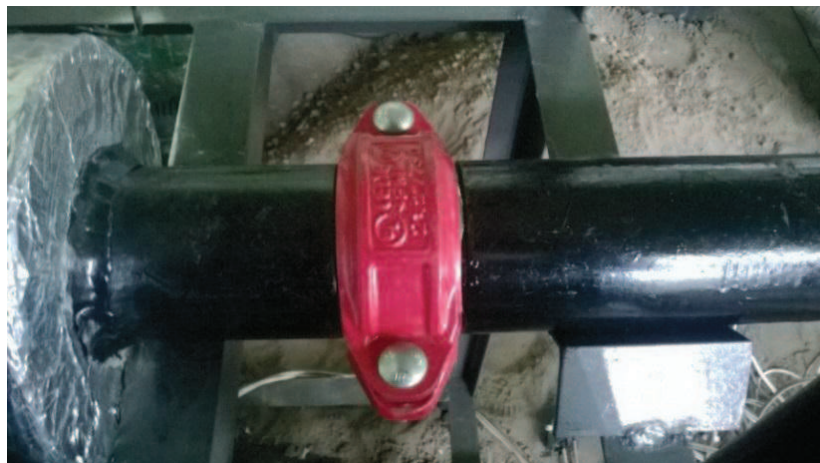
Figura 4-32 Unión de los tramos mediante junta flexible
