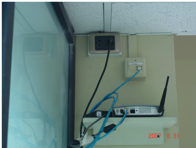
Figura 3.15 Repisa de madera para ubicación de un determinado Punto de Acceso
