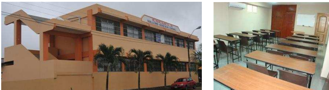
Figura 3. 1 Bloque de aulas construido por el DINSE. Fuente: Propia
