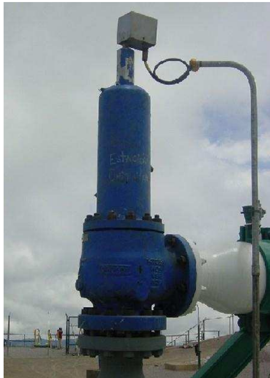
Grafico 46. Válvula de seguridad PSV-06015
