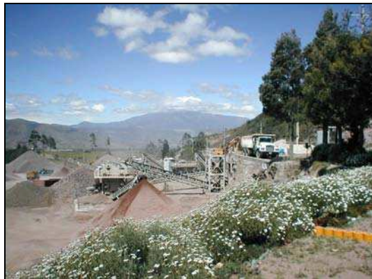
Fotografía No. 5. Instalaciones generales, pilas de materiales. Autor: Castillo, Bravo
