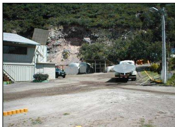
Fotografía No. 3, Oficinas y tanques de almacenamiento combustible y agua.
