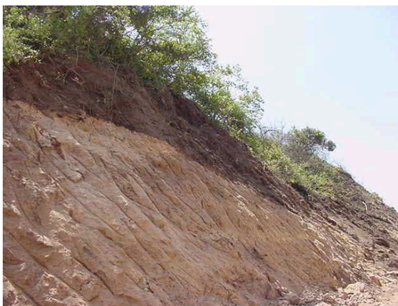
Foto No. AR1: Revisión de taludes para determinar la presencia de indicios Arqueológicos
