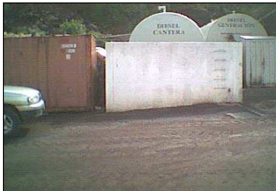
Fotografía No. 8. Tanques de combustible de cantera y de generadores eléctricos. Autor: Castillo, Bravo
