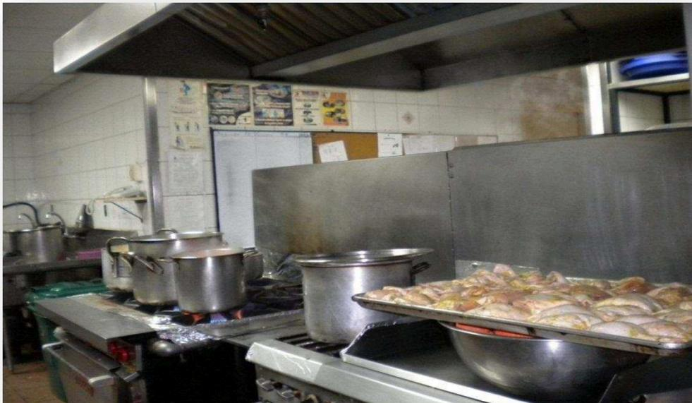
**Figura No. 26** Extractor de olores y vapores funcionando adecuadamente
