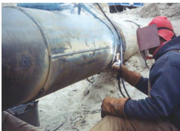
Figura 5.26 Ejemplo de tubería con envoltente metálica tipo B [5]
