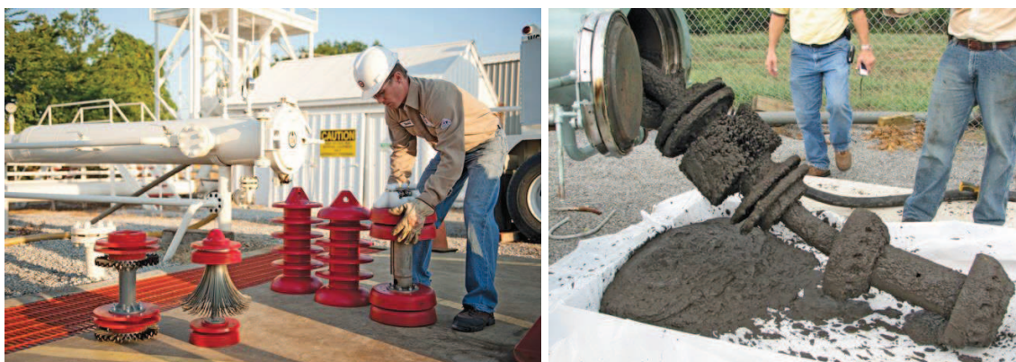
Figura 2.8. Equipos de limpieza y retiro de suciedad en un ducto. 9
