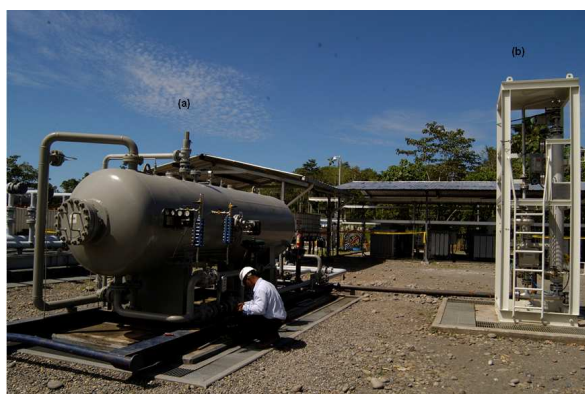
Gráfico Nº 1.3.2: Sistema de medición de pozos multifásica: a) separador de prueba tradicional (b) medidor multifásico.
