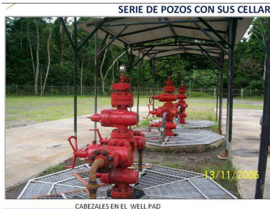
Gráfico N° 1.3.3: Cabezales de pozos en superficie.
