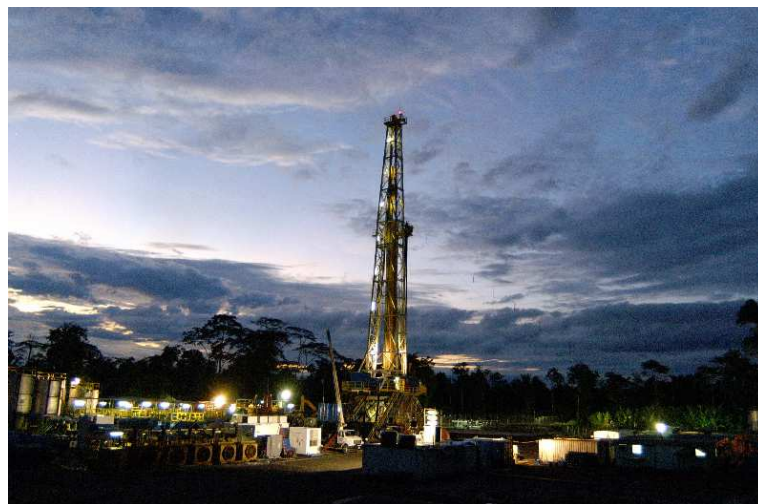
Gráfico Nº 1.2.1: Torre de perforación en el Oriente ecuatoriano
