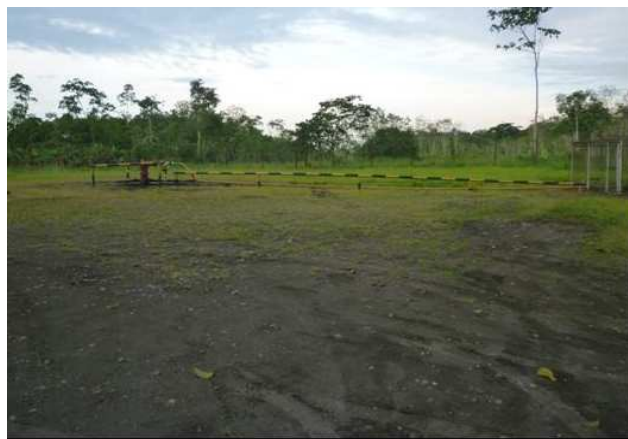
Gráfico N° 1.2.2: Instalación de tubería
